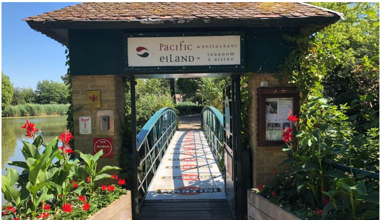
Figuur 3 bestaande toestand: zicht op de brug vanaf de vesten
