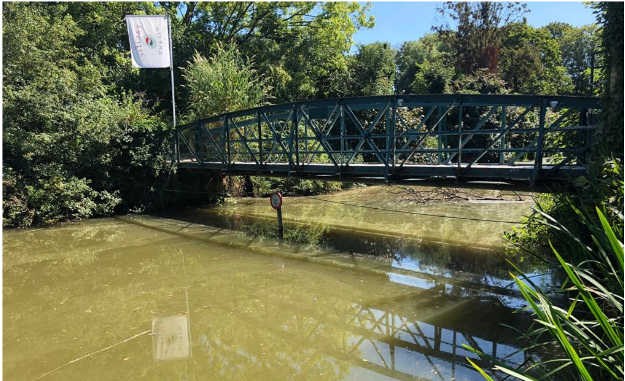
Figuur 2 bestaande toestand: zicht op de brug vanaf de vesten
