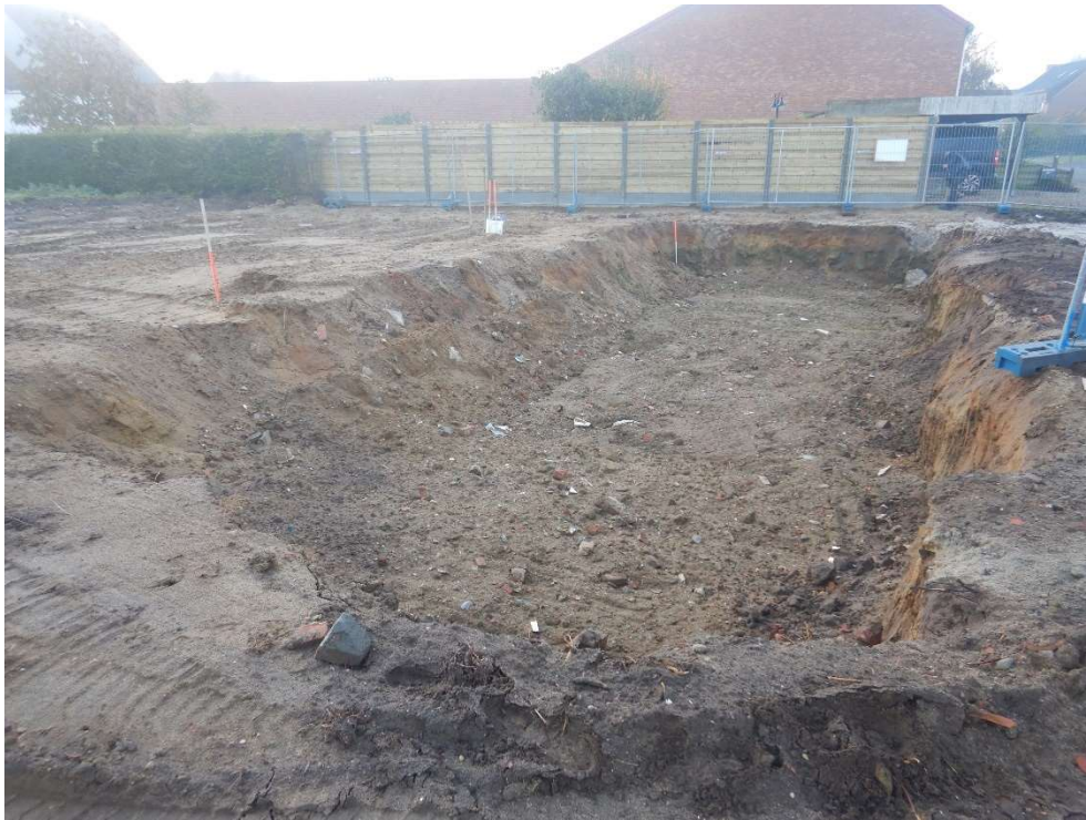
Figuur 17: Werkfoto uitgebroken kelder
