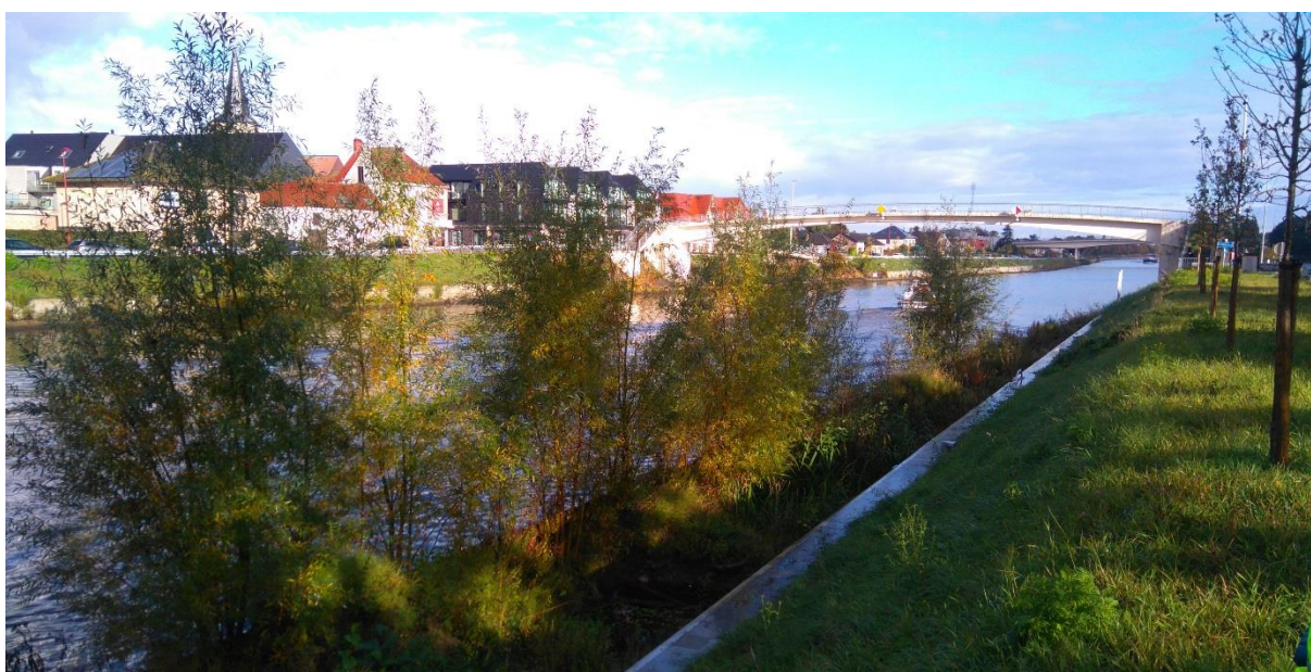
Figuur 7: Zicht op de nog weg te halen grond ter hoogte van de passeerstrook (reeds 1m afgegraven).
