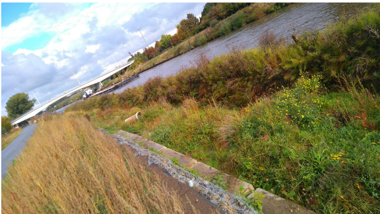
Figuur 11: Zicht op de reeds geplaatste nieuwe wand en de nog weg te graven grond tussen de oude en nieuwe wand. Foto genomen ter hoogte van bocht 46.
