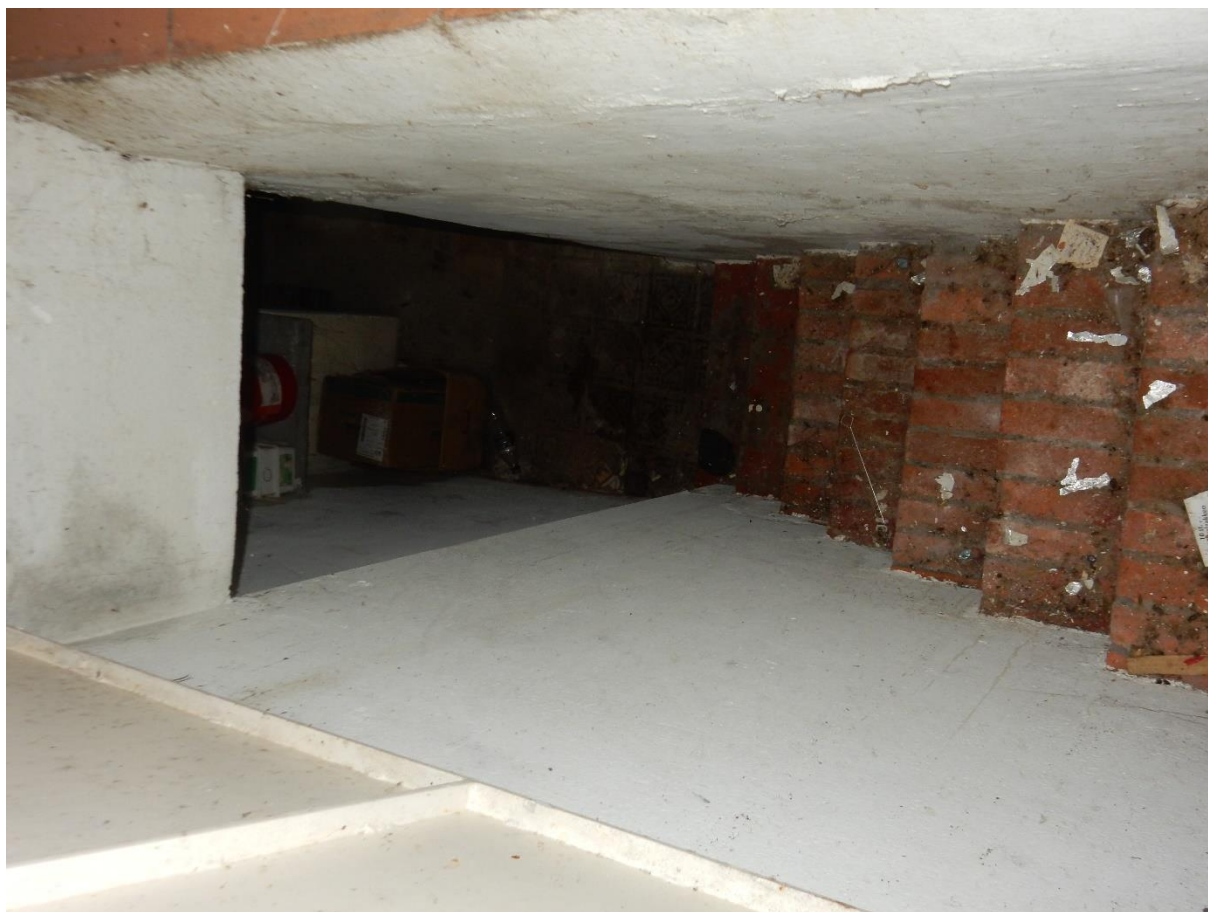
Foto 13: Toegang kelder nr. 121
