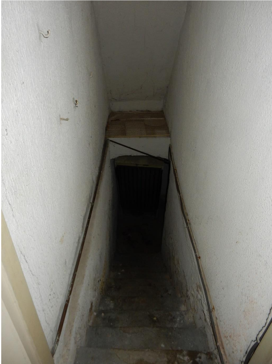
Foto 7: Toegang kelder nr. 117
