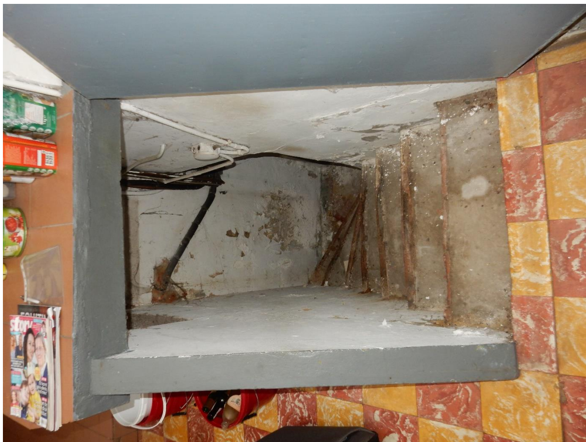
Foto 9: Toegang kelder nr. 119
