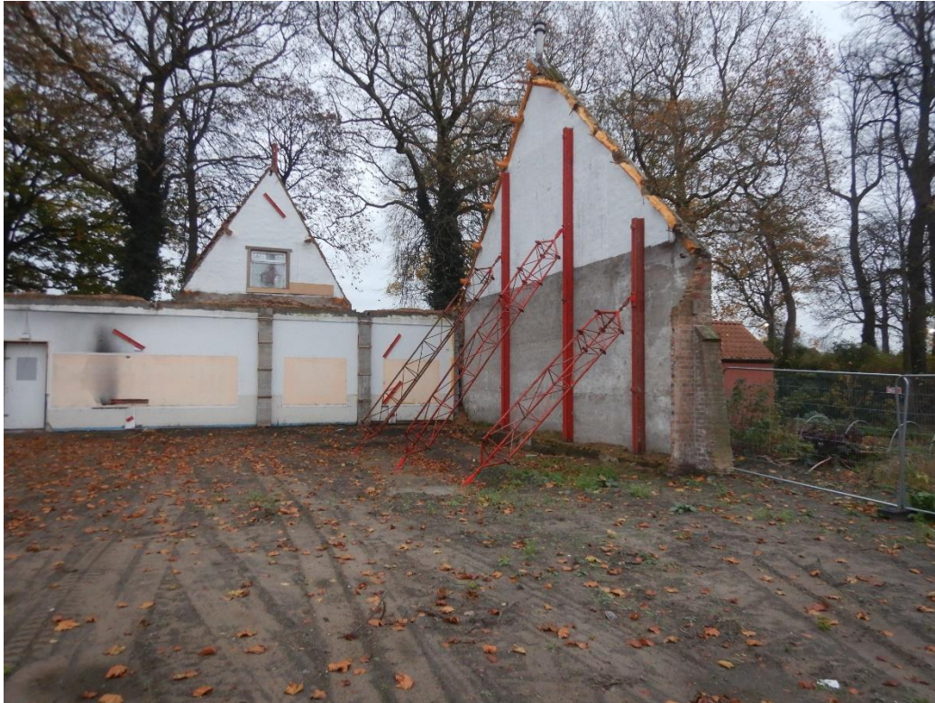
Figuur 16: fotografische opname van de oostzijde van het projectgebied met zicht op de stutting.
