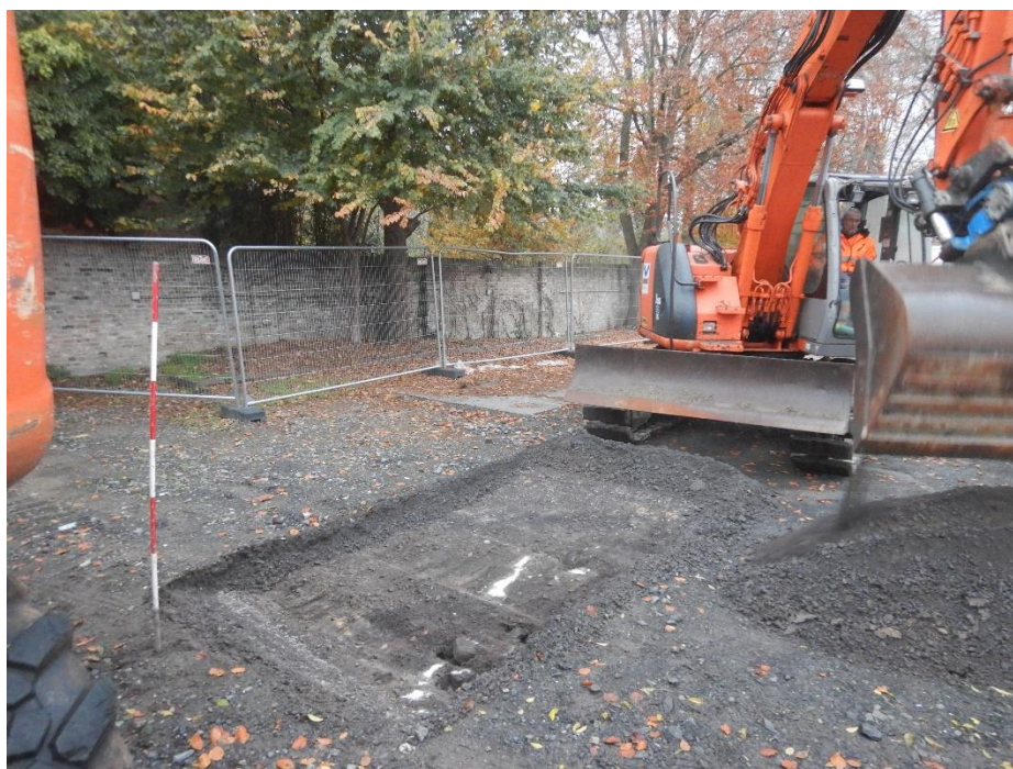
Figuur 8: aanleg van werkput 1 met op de achtergrond de aanwezige asfaltering met bomen.
