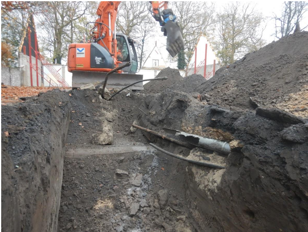
Figuur 23: fotografische opname van de aanwezigheid van leidingen bij de aanleg van werkput 1.
