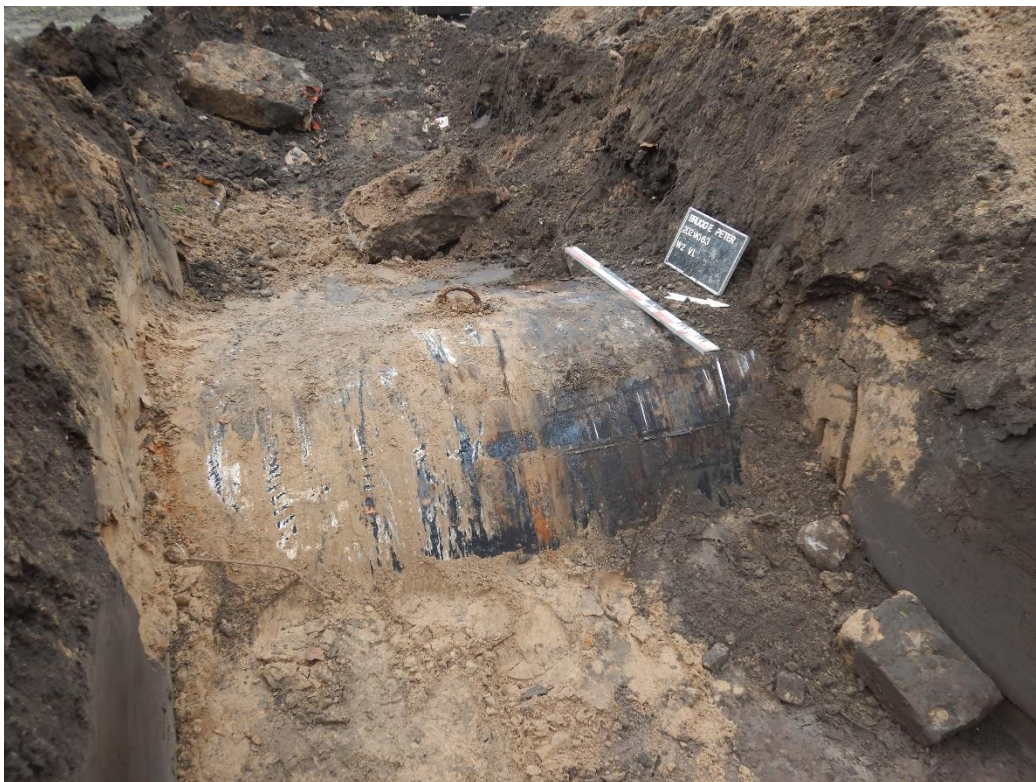
Figuur 27: fotografische opname van de mazouttank in werkput 2.
