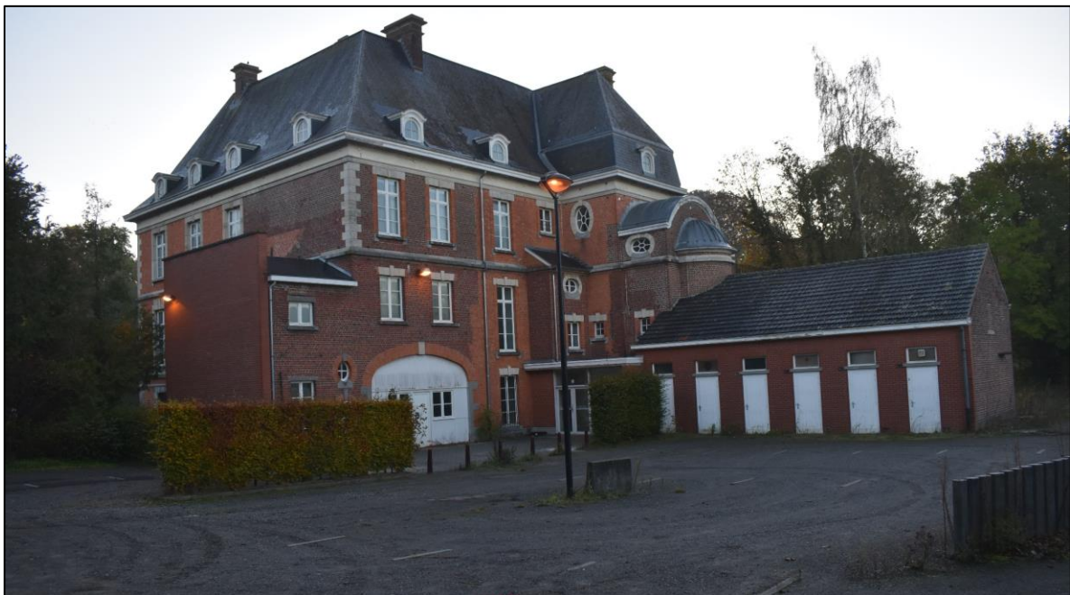
Afb. 31: Overzichtsfoto van de achterkant van het kasteel de Maurissens (Bron: Aron bv, dd. 28/10/2021, 2021J286).
