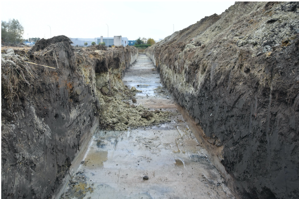
Fig. 3.30: Ingestorte sleufwand van Sleuf 3, ter hoogte van de in blauw aangeduide anomalie op het geofysisch onderzoek.
