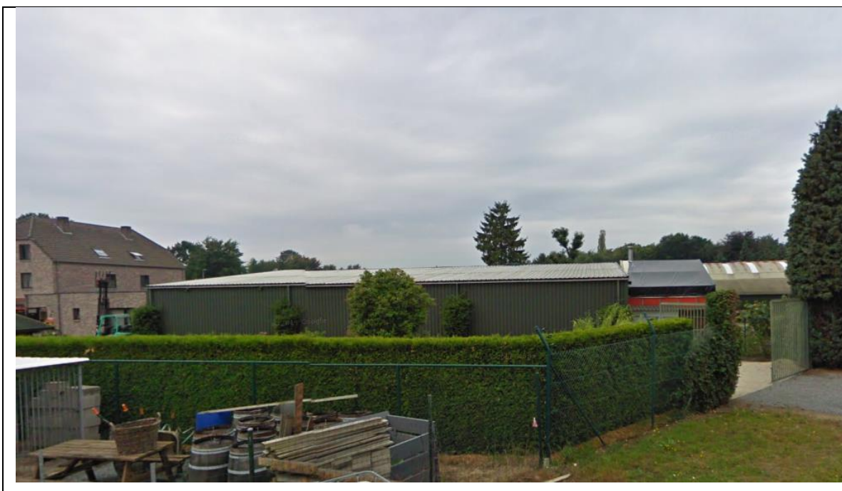
Figuur 6: Bestaande situatie - achterzijde
