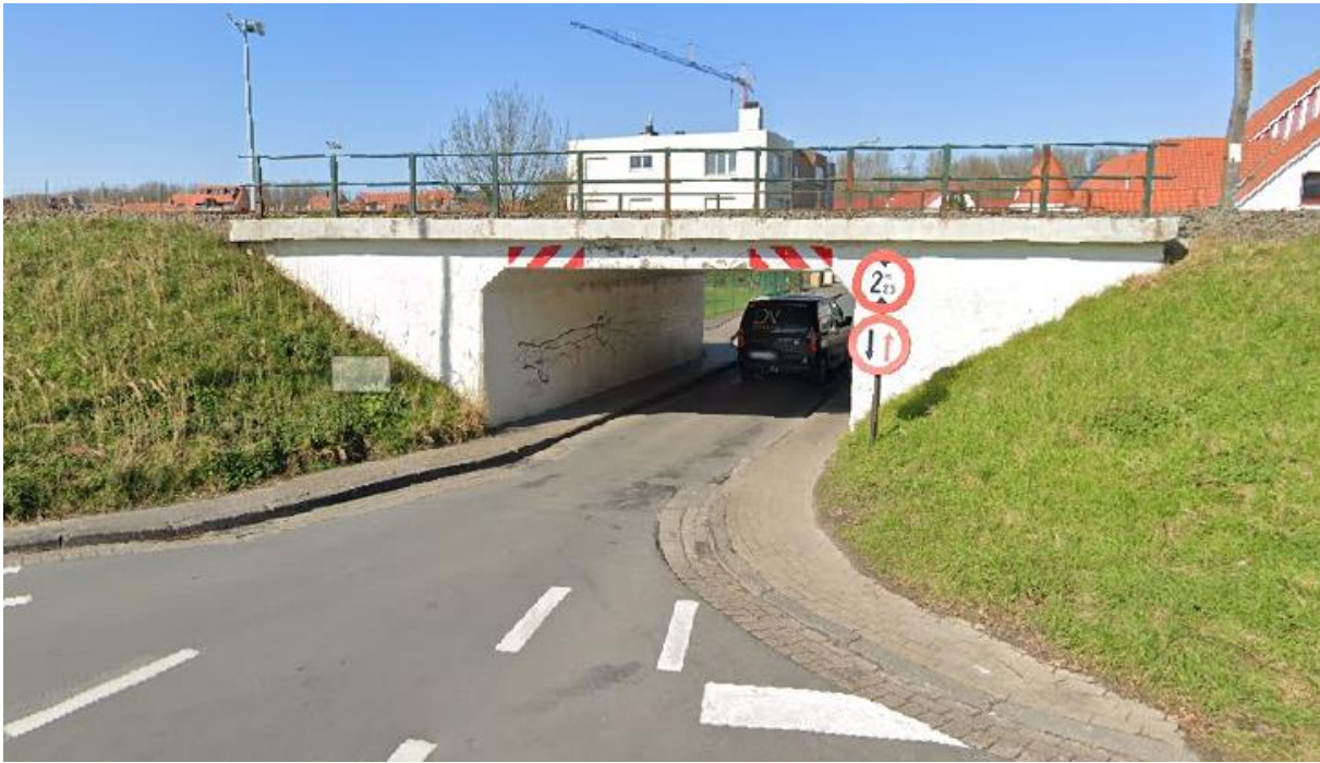
Figuur 13: Spoorbrug ter hoogte van Krommedijk (© Google Streetview)
