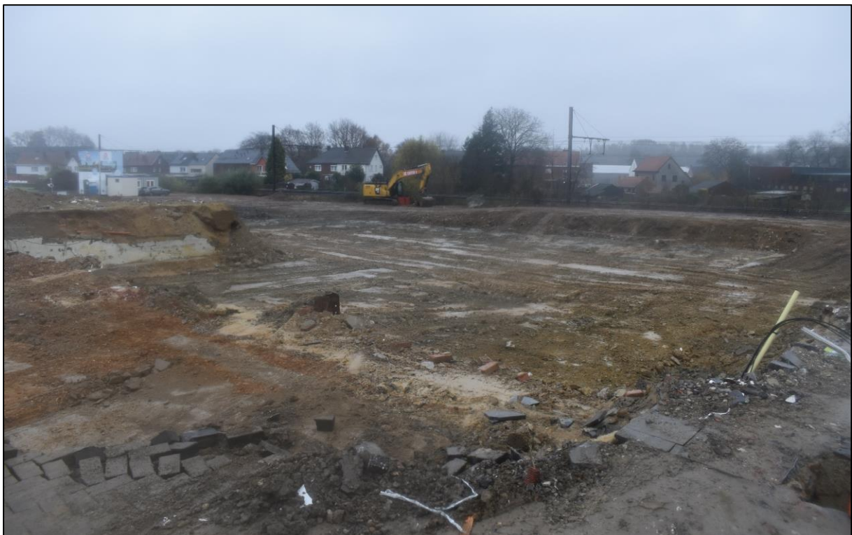
Afb. 14: Overzichtsfoto van het onderzoeksgebied bij aanvang van het landschappelijk bodemonderzoek. Foto genomen uit het zuidwesten (Bron: Aron bv, dd. 30/11/2021, 2021K105).
