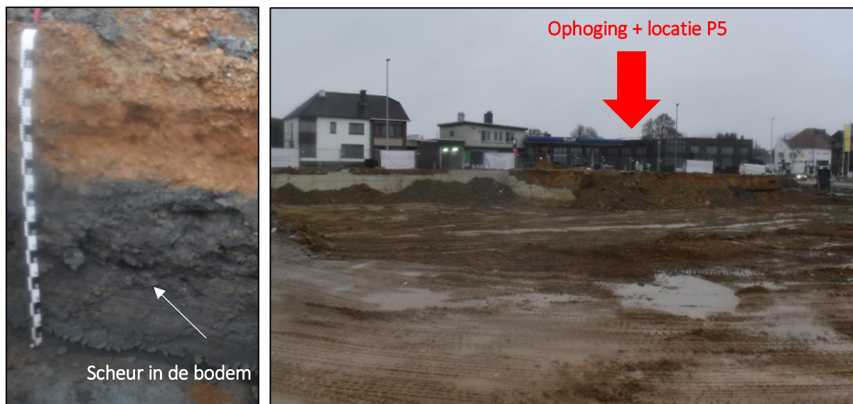
Afb. 22: Volledig opgehoogd en verstoord profiel over een diepte van 2m, dat net na het nemen van de foto instortte.
