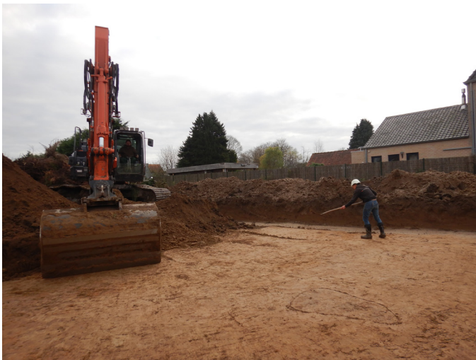
Figuur 13: Aanleg van een kijkvenster
