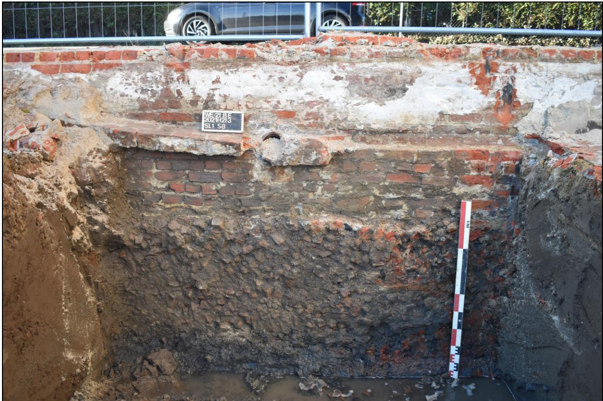
Afb. 37: Sleuf 1: muur S8 van de voormalige bierkelder gesitueerd tegen de Beverlaak.
