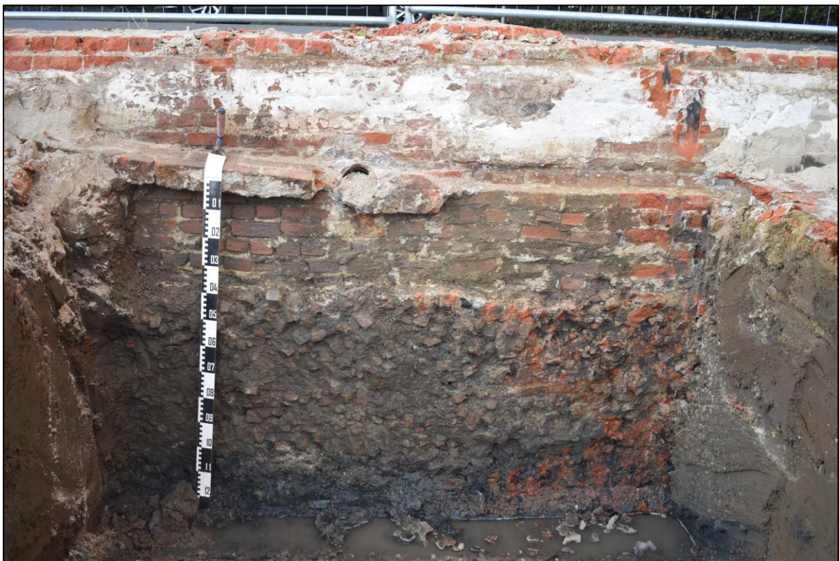
Afb. 20: Bijkomende proefput ter controle van de aanwezige funderingen aan het westelijke uiteinde van sleuf 1 met grond- en/of rioolwater aan de straatzijde.
