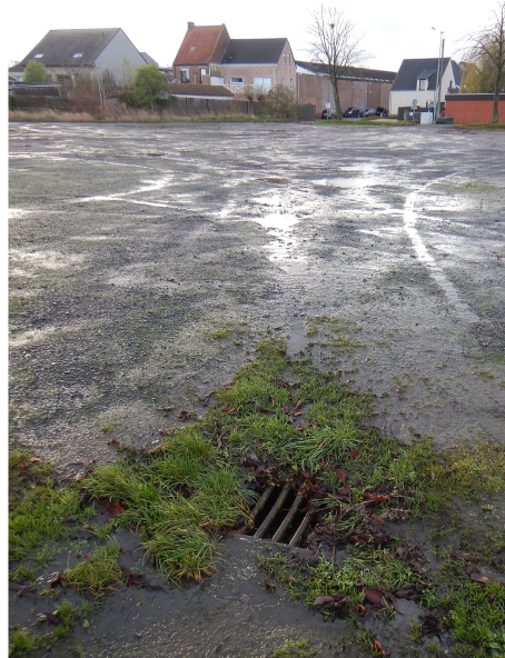
Figuur 7. Zicht op de centrale waterafvoer richting de Kattestraat.
