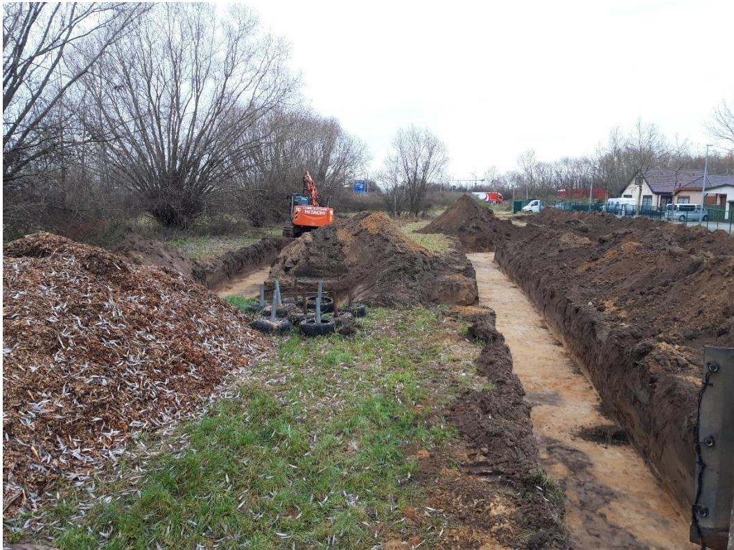
Figuur 9: Zicht op de aanleg van sleuven 1 en 2 tijdens het proefsleuvenonderzoek (bron: MVDK).
