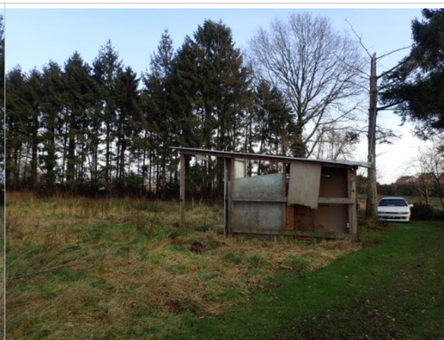
De zuidelijke perceelsgrens vanuit het westen
