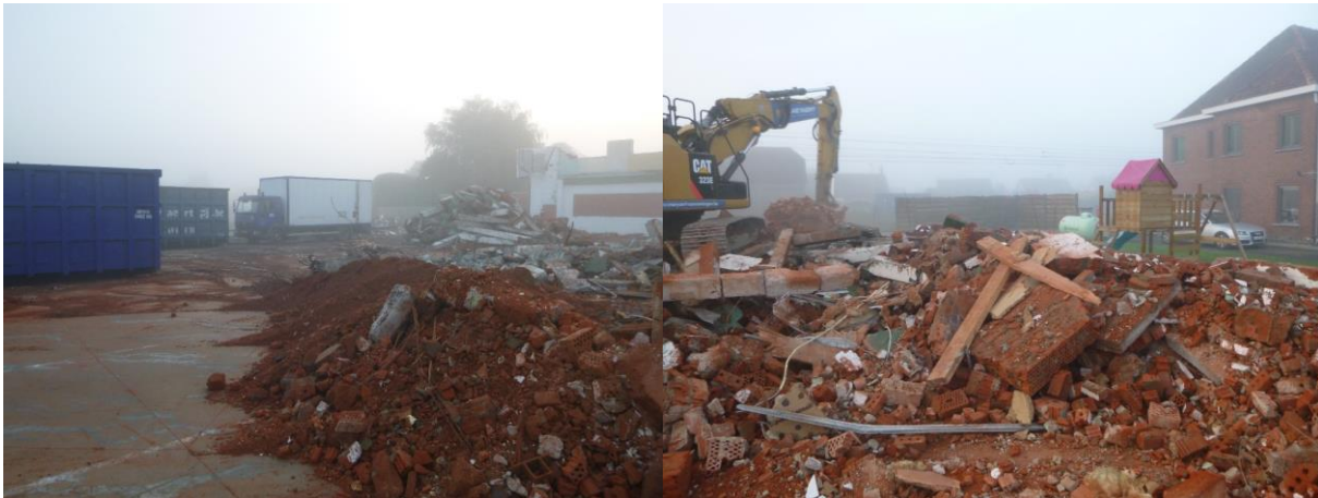
Figuur 11: Omgevingsfoto's ter hoogte van BP10, genomen in noordelijke (links) en zuidelijke richting (rechts).
