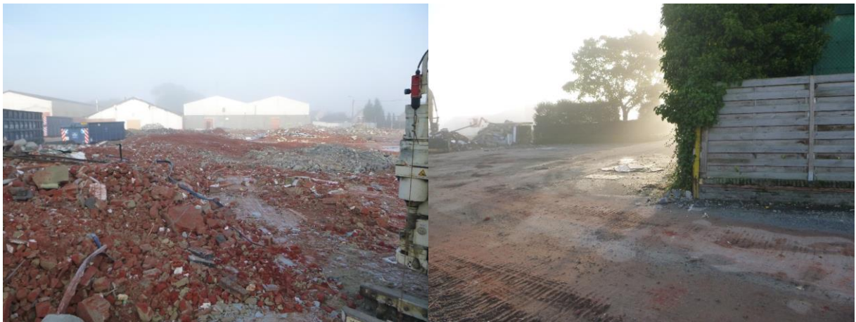
Figuur 9: Omgevingsfoto's ter hoogte van BP8, genomen in westelijke (links) en noordoostelijke richting (rechts).
