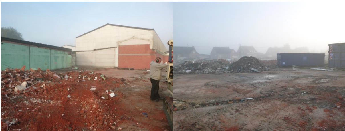
Figuur 7: Omgevingsfoto's ter hoogte van BP6, genomen in westelijke (links) en noordoostelijke richting (rechts).
