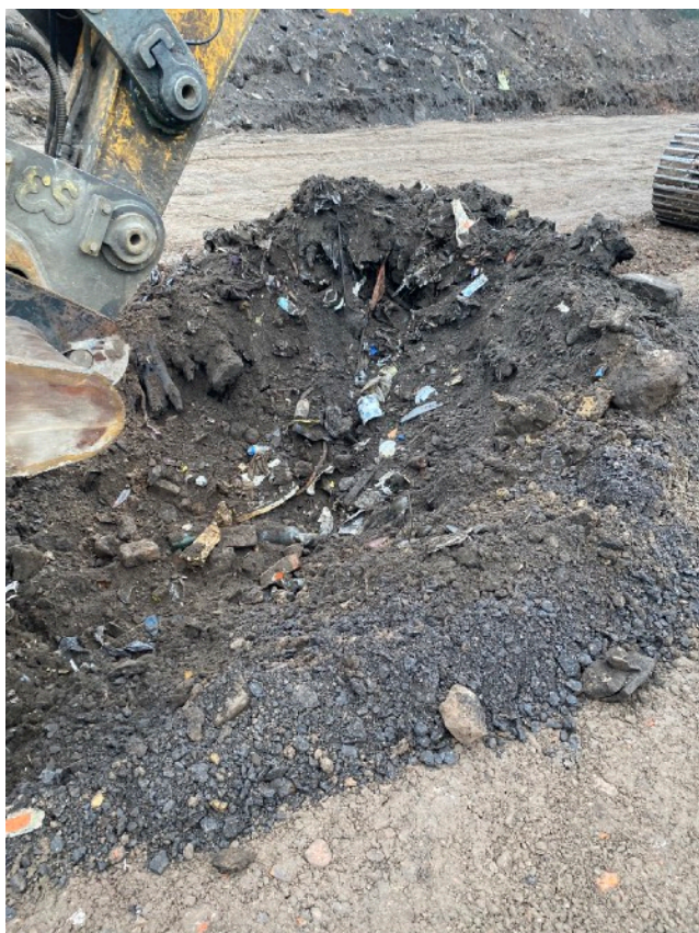
Fig. 3 Zicht op de laag huishoudelijk afval bij de start van het graven van profielput B1.
