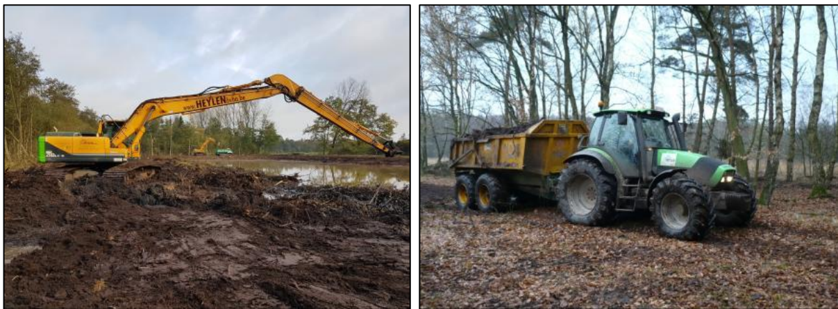
Figuur 7: Long reach kraan en dumper (Initiatiefnemer 2021)
