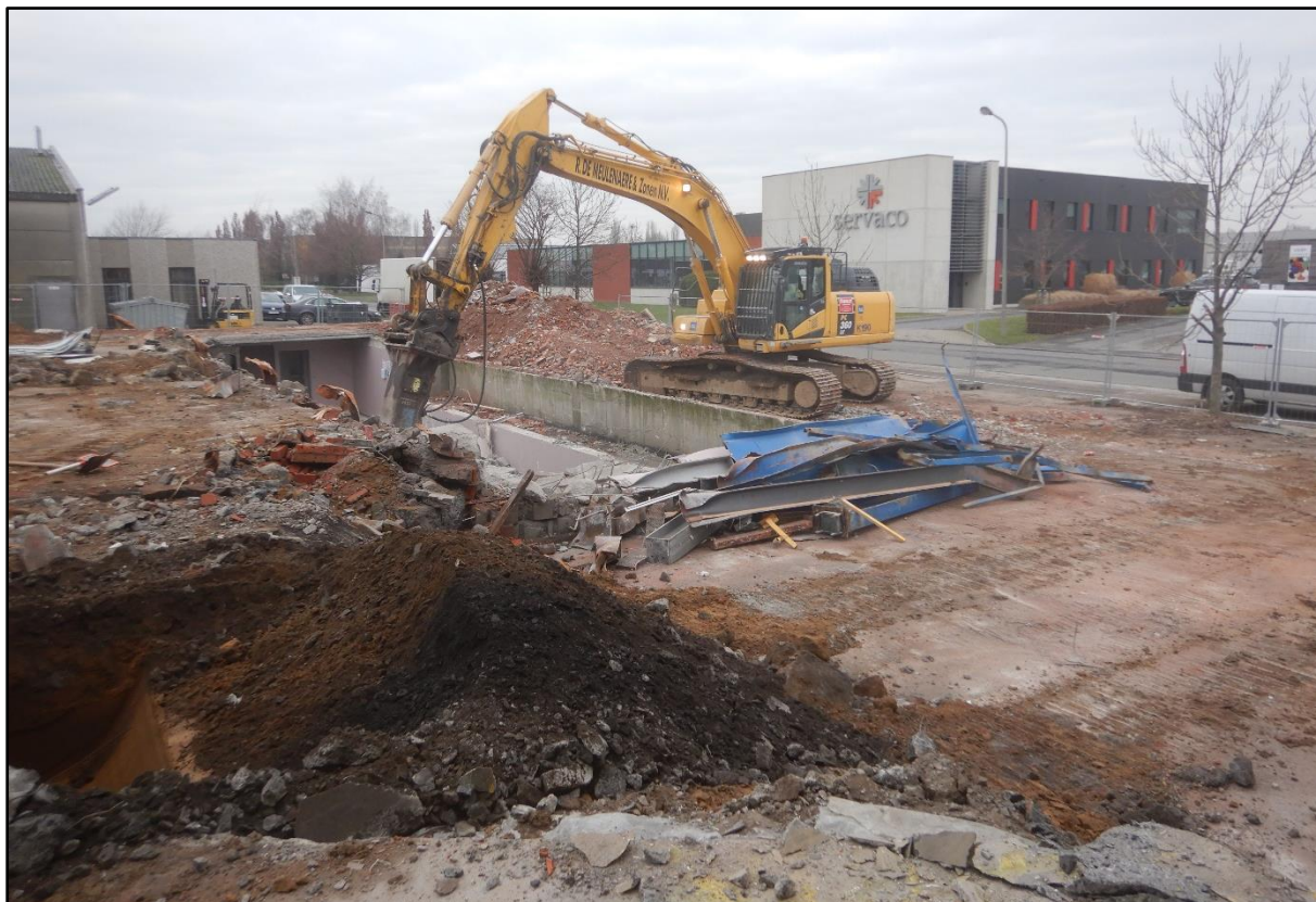
Figuur 5 Zicht op het meest oostelijke deel van het terrein aan de Vlamingstraat. Deze strook bevindt zich beduidend lager dan het archeologische vlak. Ook de kelder, centraal zichtbaar op de foto, vormt een diepgaande bodemverstoring. Links is de aanzet van sleuf 3 te zien met een diepere profielput.
