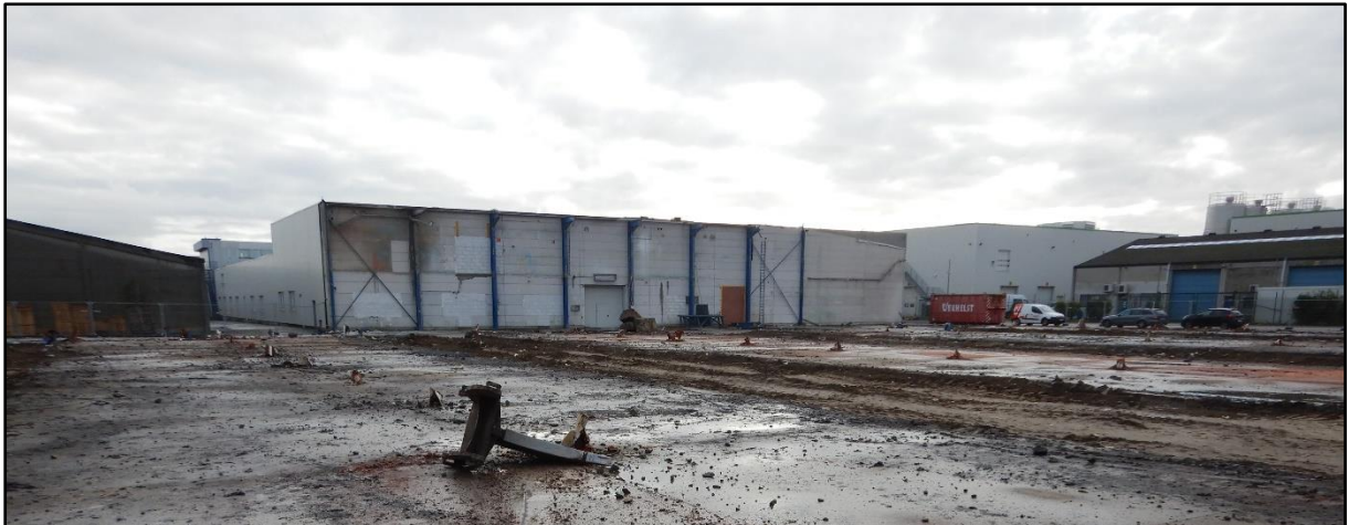
Figuur 1 Zicht op de grote loods (fase 2) voor de afbraak (foto genomen vanaf het westelijke deel – fase 1).
