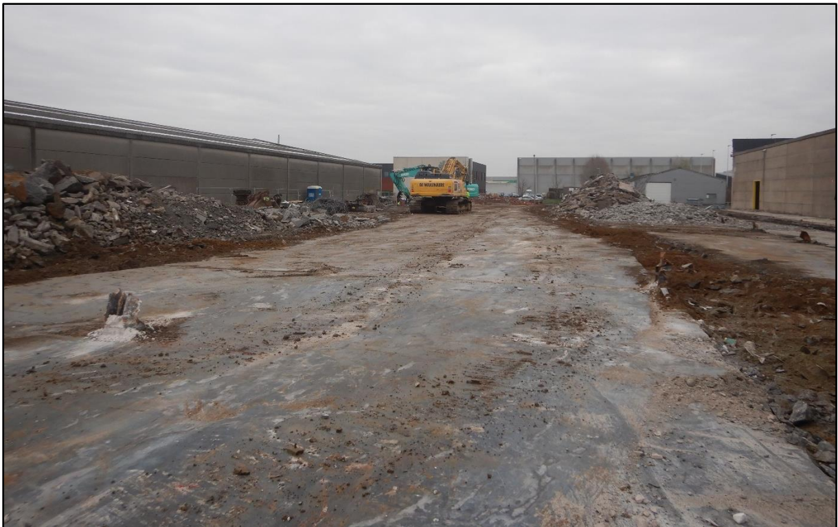
Figuur 2 Zicht op de zone van fase 2 na de bovengrondse sloop. Merk ook aan de linkerzijde één van de vele metalen pijlers met betonfundering.
