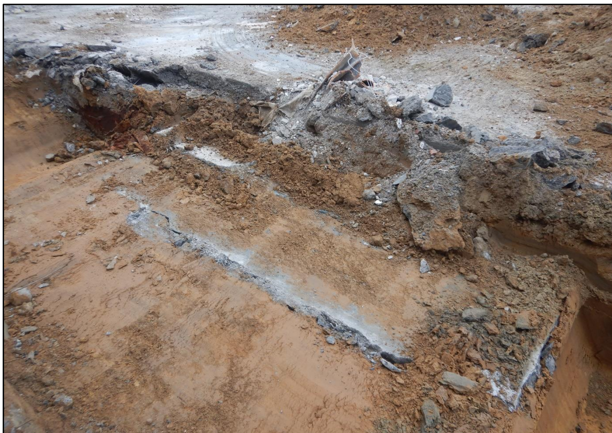
Figuur 3 Sfeerbeeld tijdens het sleuvenonderzoek met zicht op de betonfunderingen en centraal de metalen peiler.
