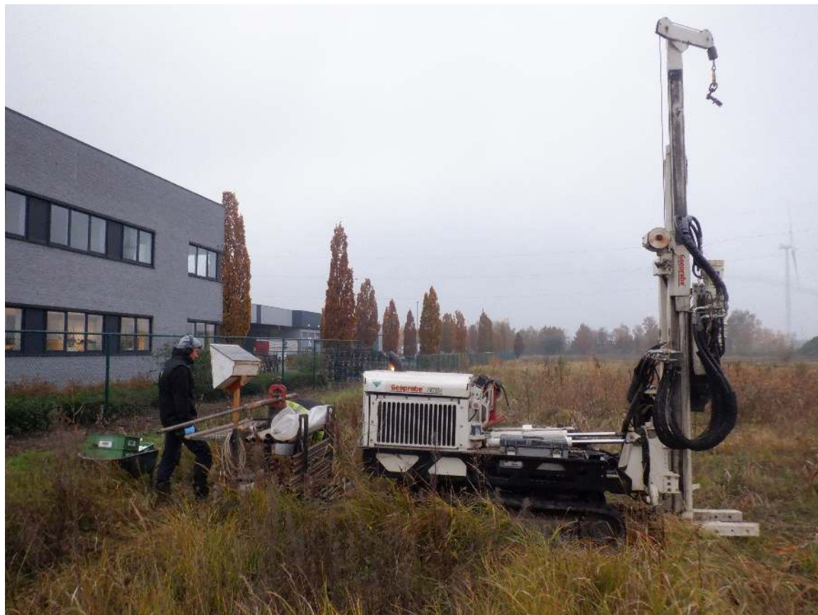
Afbeelding 3.6.1: Uitvoering van boring 25 met de geoprobe.
