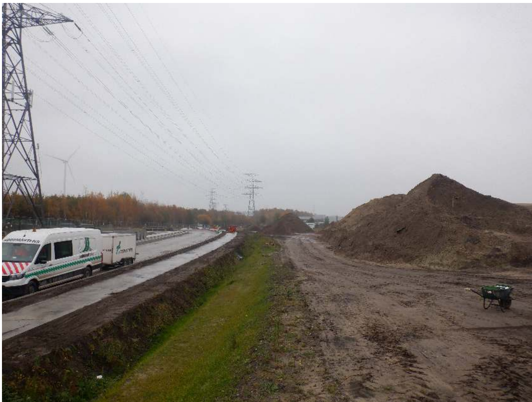
Afbeelding 3.6.3: Grote gronddepots domineren het noorden van het plangebied. Links kan de nieuwe Mondeolaan herkend worden. De foto is genomen ter hoogte van boring 1 in oostelijke richting.
