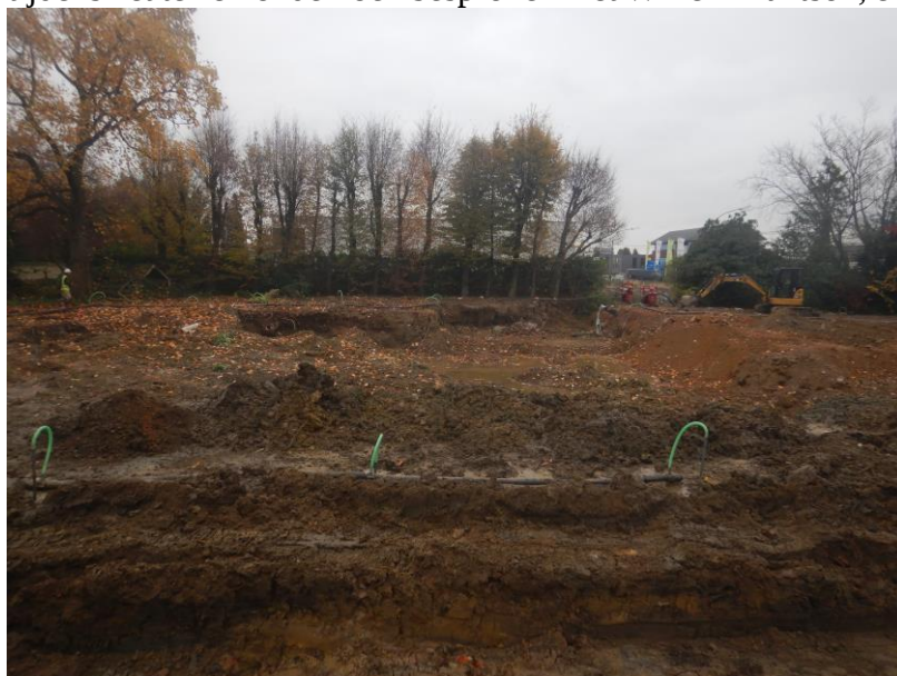
Figuur 9: Zicht op het bemalingskader en de uitgraving vanaf het zuiden.
