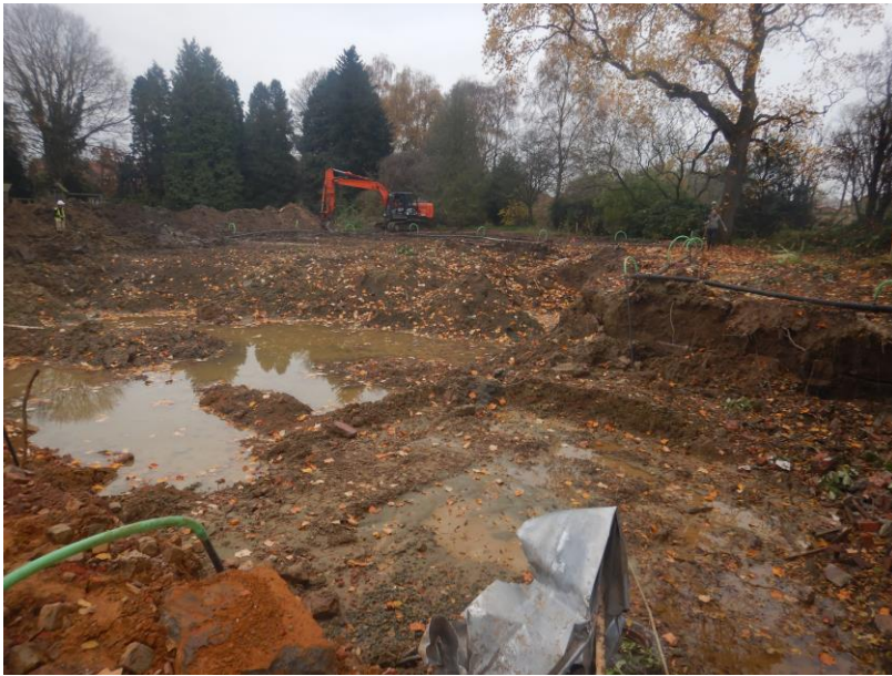
Figuur 10: Zicht op het kader en de uitgraving vanuit het noordoosten.
