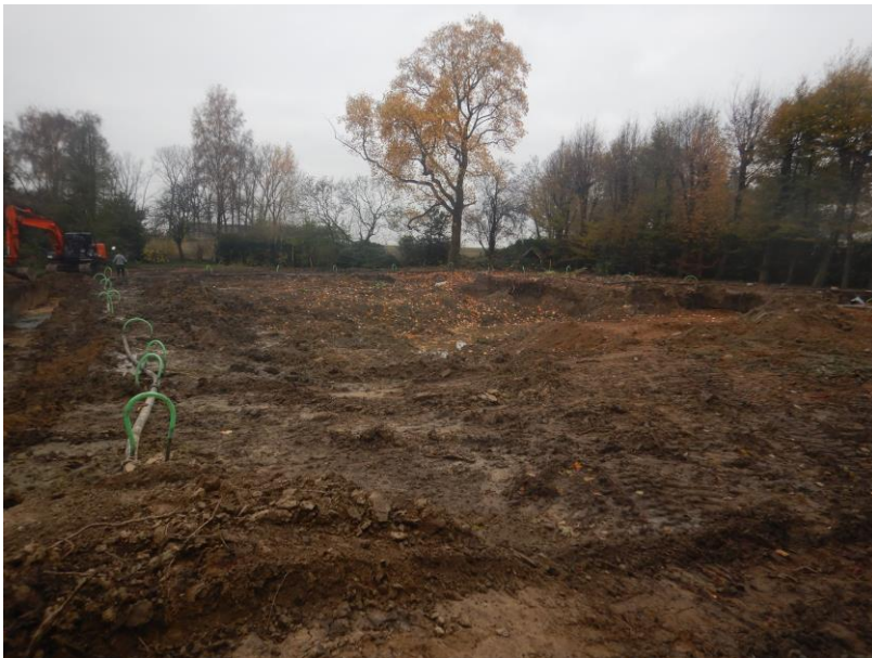
Figuur 11: Zicht op het bemalingskader vanuit het oosten.
