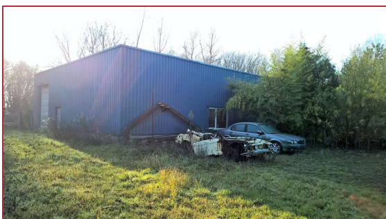
Foto 3: Voorgevel van de loods in de centrale zone (NO-ZW).
