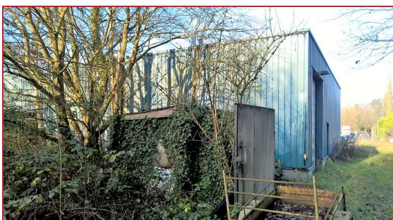
Foto 5: Achtergevel van de loods (Z naar N).
