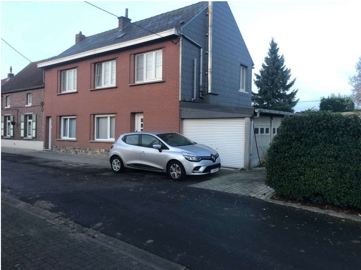
Figuur 3: Foto van de bestaande toestand. Zicht op het huis en de garage met verharding (in ZW richting) (Initiatiefnemer 2021).
