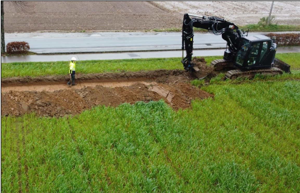
Figuur 23: Werkfoto van het aanleggen van de proefsleuven (ABO nv 2021)
