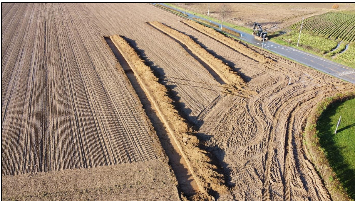
Figuur 22: Dronefoto van de aangelegde sleuven (1 t.e.m. 3) ter hoogte van het terrein voor grondverbetering (ABO nv 2021)
