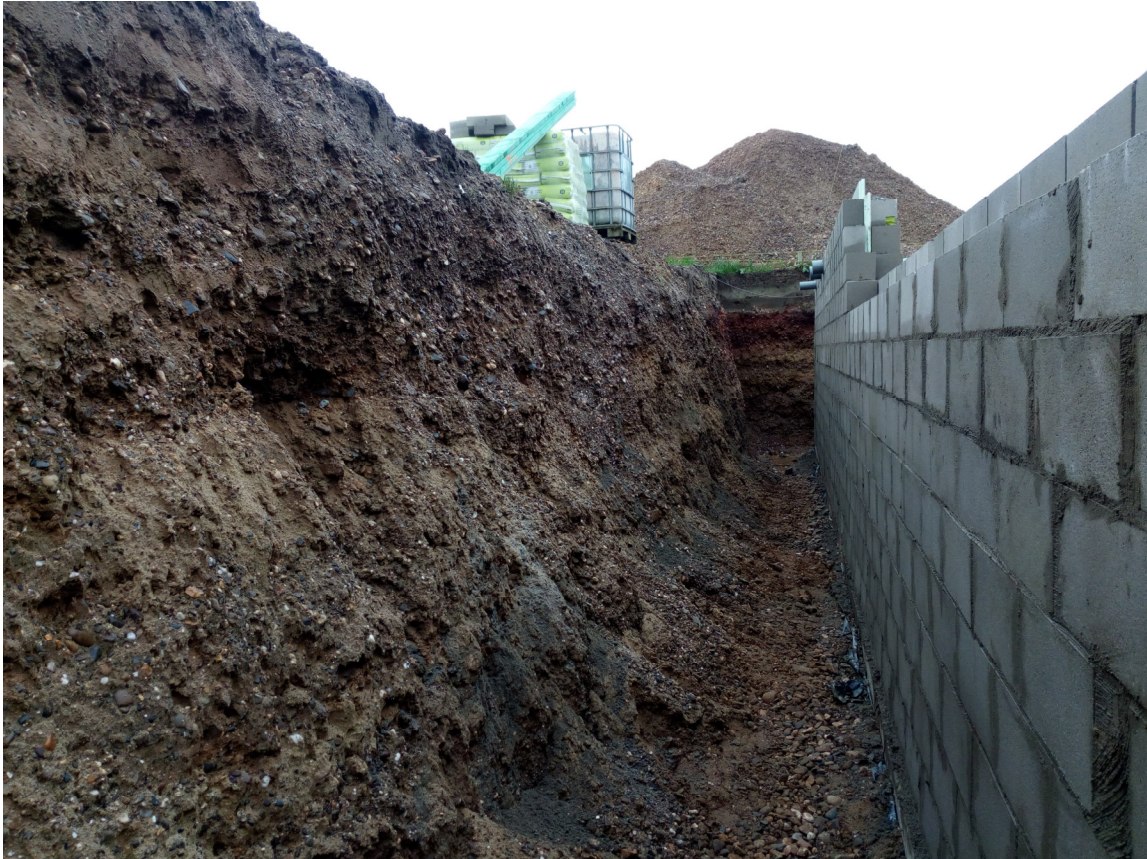
Afbeelding 4.2.10: Impressie van het bodemprofiel met de diverse grinden en grove zanden.
