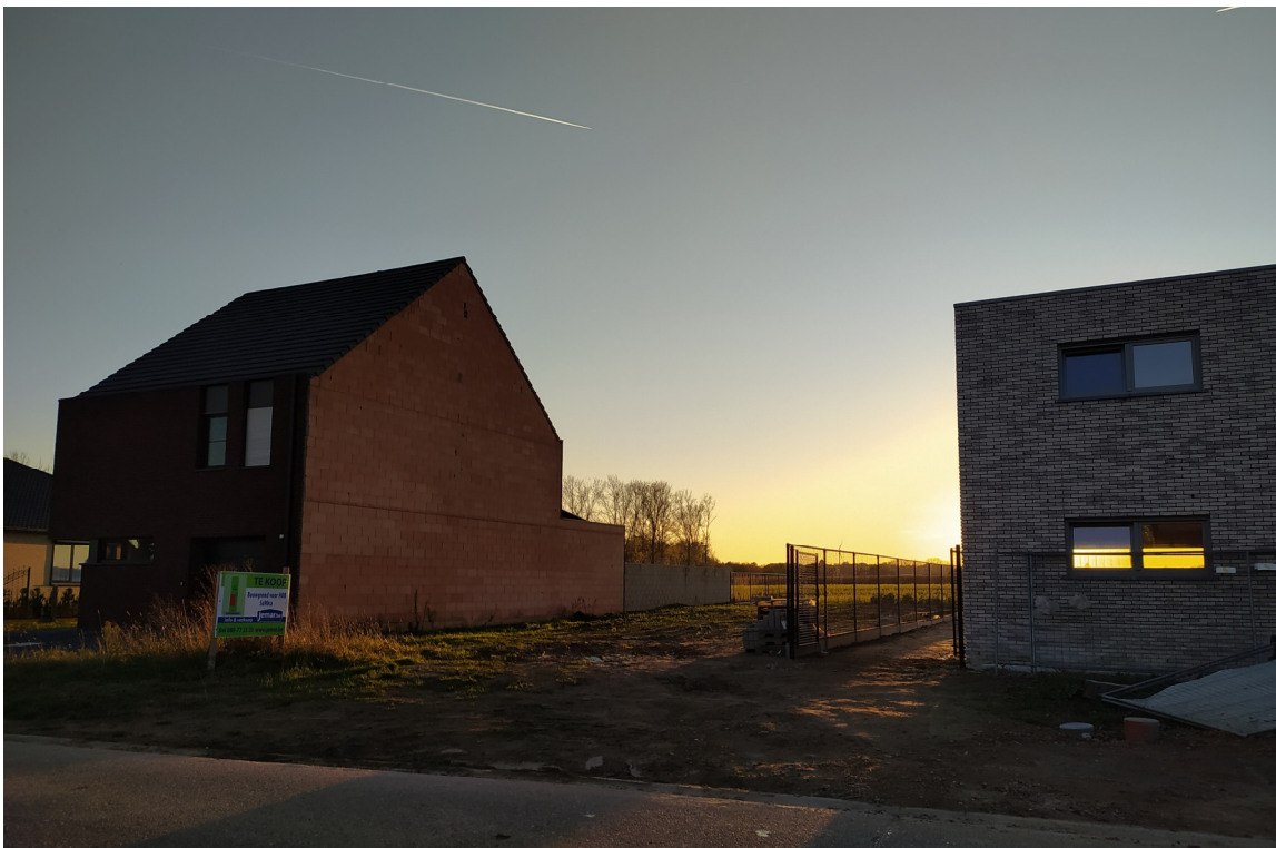
Afbeelding 3.3.1: Impressie van het plangebied bij een visuele inspectie.
