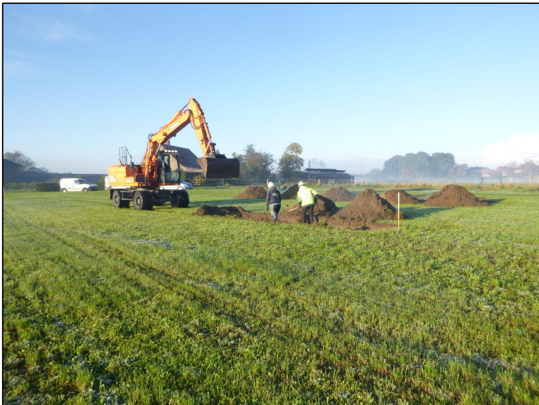
Figuur 50: Uitvoering van sleuven (ABO nv 2021)
