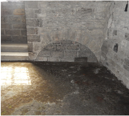
Figuur 38. Zicht op de Nederschelde en het Duivelsteen (1562) 25 . Uiterst rechts is de watertrap aan de "Wijden Aard" zichtbaar. Aan de linkerzijde van de grote toren wordt een volgende watertrap weergegeven. Onder: de dichtgemaakte watertrap in de crypte. Voorafgaand aan de renovatie van het steen in 1897 was deze al dicht.
