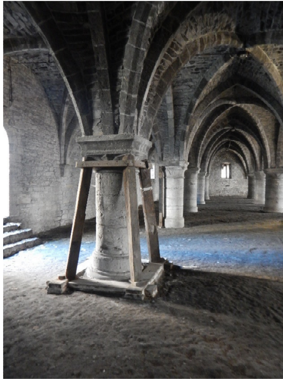
Figuur 8. De gestutte pijler tijdens de begeleiding van de sonderingsputten in juni 2020.
