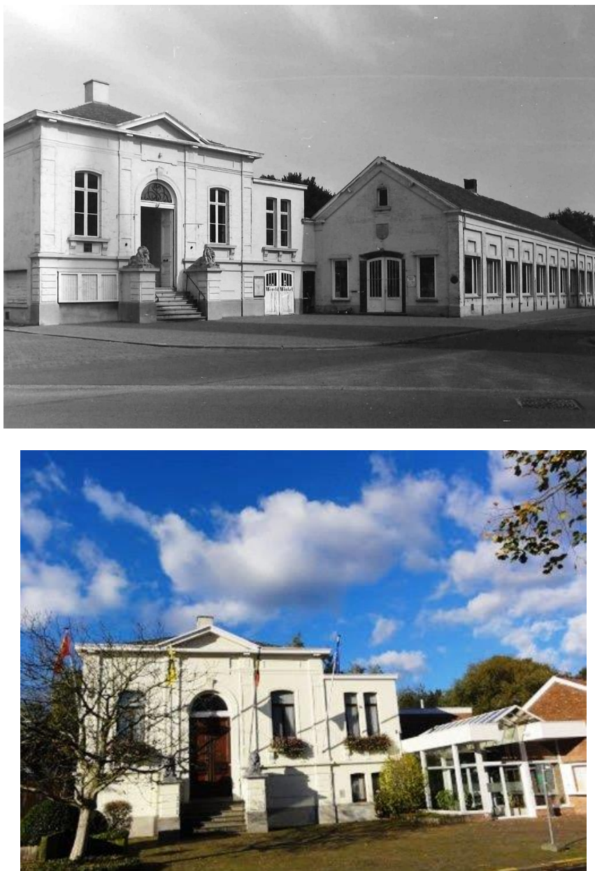
Figuur 41: Weergave van gemeentehuis van Kalmthout. Bovenste afbeelding is een weergave van de voormalige school. Onderste afbeelding is de uitbreiding (voormalige school dat verbouwd lijkt te zijn) dat volledig zal afgebroken worden. 54
