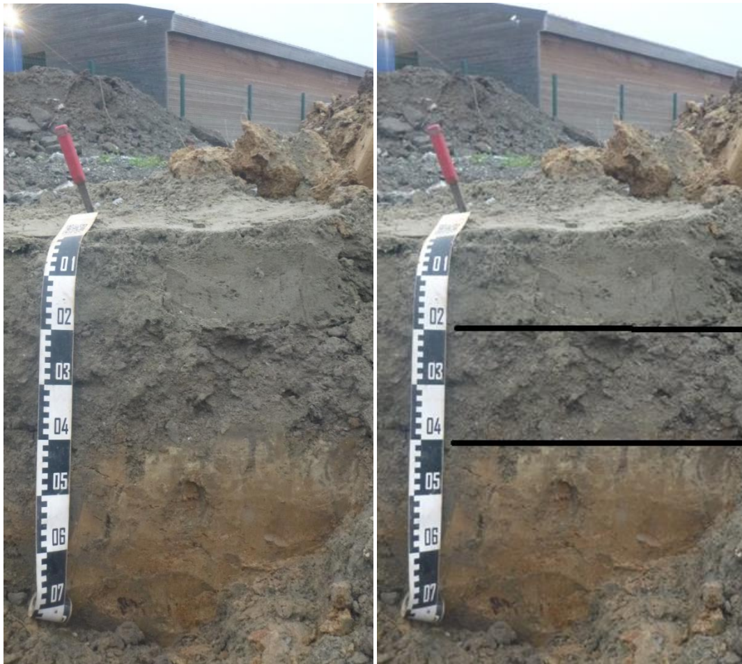
Figuur 9: Bodemopbouw na verwijderen van de betonplaat met rechts aanduiding van de funderingslagen.
