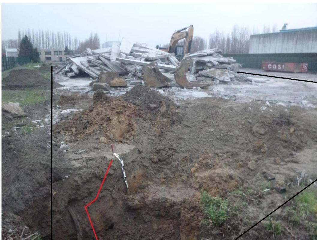
Figuur 8: Verwijderen van betonnen vloerplaat en uitgraving van bestaande funderingsvoet. Locatie van profiel bodemopbouw onder bestaande loods. In zwart de contourlijn van de betonplaat, in rood de aflijning van de sleuf die gegraven werd voor de aanleg van de funderingen.
