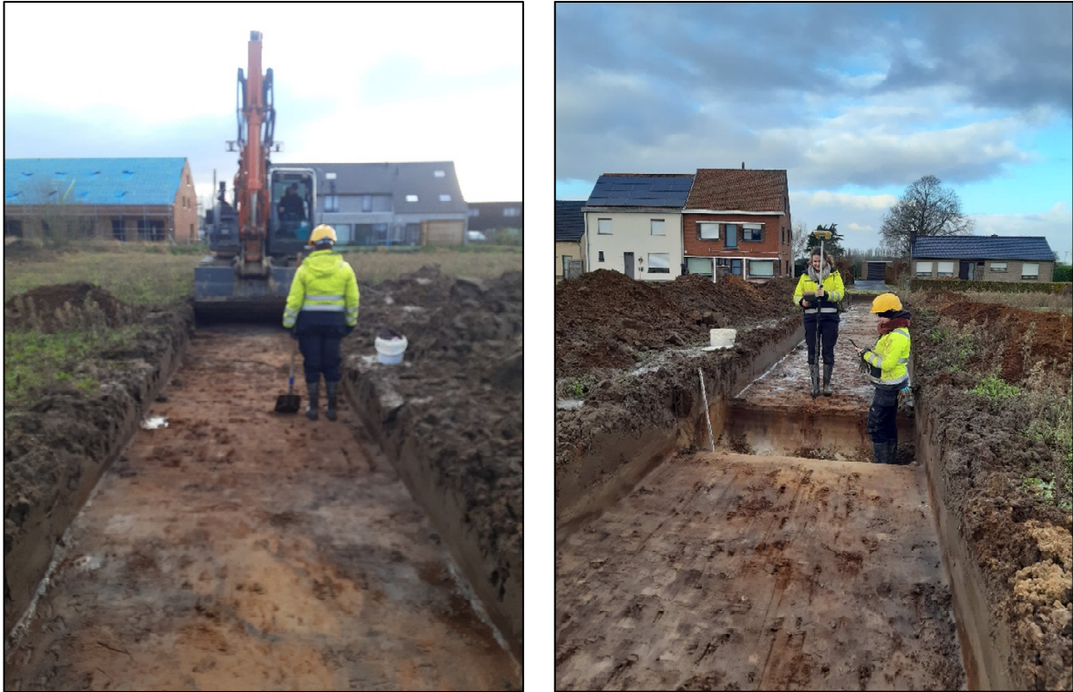
Figuur 15: Foto's methodiek (links: aanleg proefsleuven, rechts: inmeten en beschrijving bodemprofiel)
