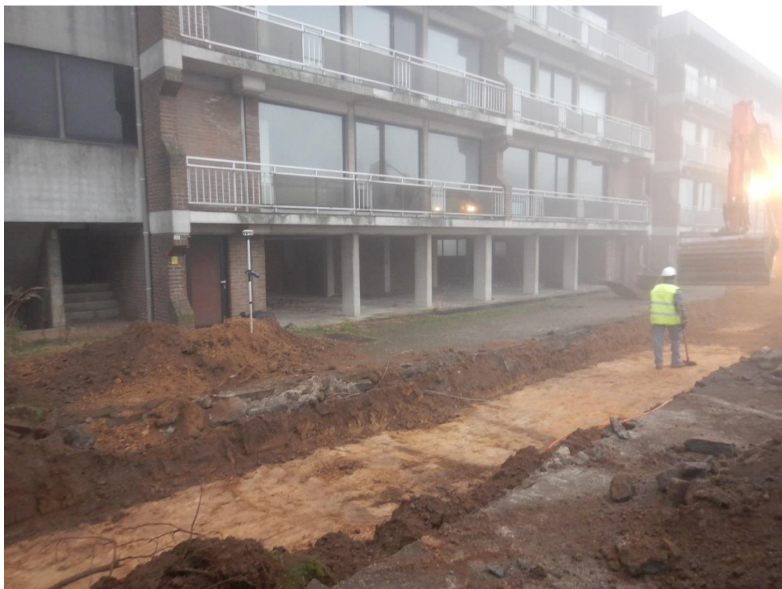
Figuur 13: Uitvoering proefsleuvenonderzoek voor sloop
