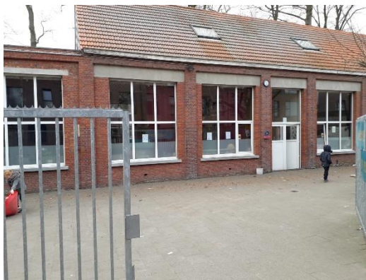
04. ingang vanaf brandweg t.h.v. blok C
