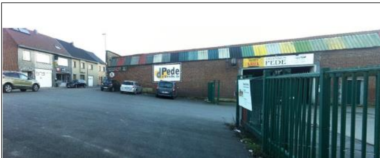
Figuur 9: Drankencentrale Pede (nu gesloopt) bevond zich binnen het studiegebied en ligt duidelijk lager dan het straatniveau van de Doelstraat (Solva 2018)
