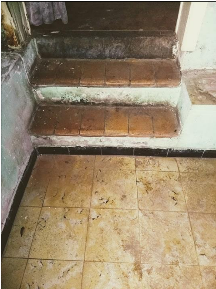
Figuur 25: Trap naar voute in westelijk gebouw.
