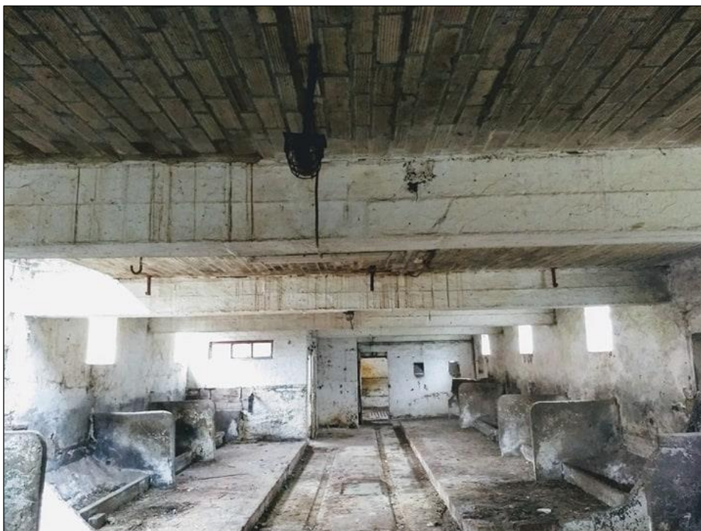
Figuur 24: verbouwd interieur noordelijk gebouw.
