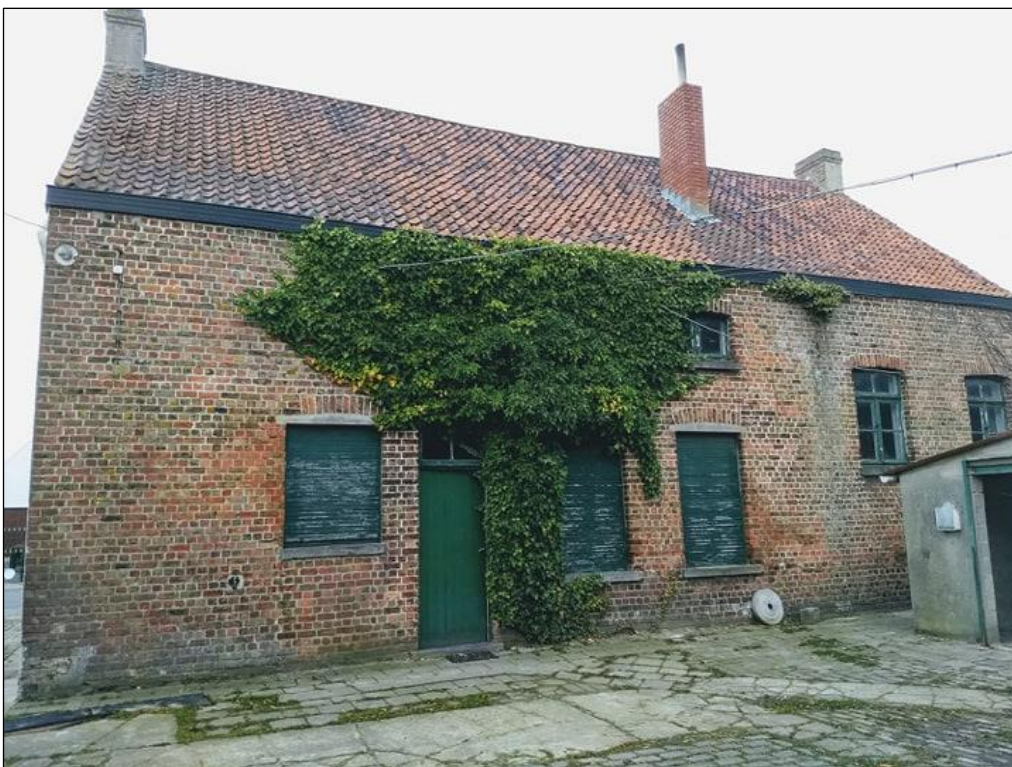
Figuur 26: Westelijk gebouw, gezien vanop de binnenkoer.
