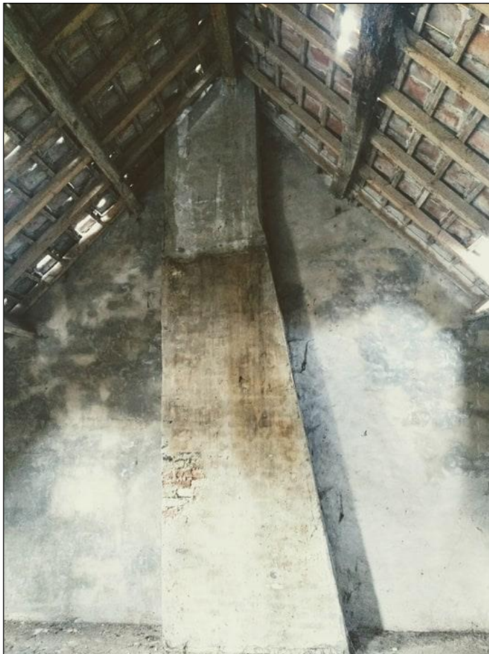
Figuur 23: Restant oorspronkelijke schouw noordelijk gebouw.
