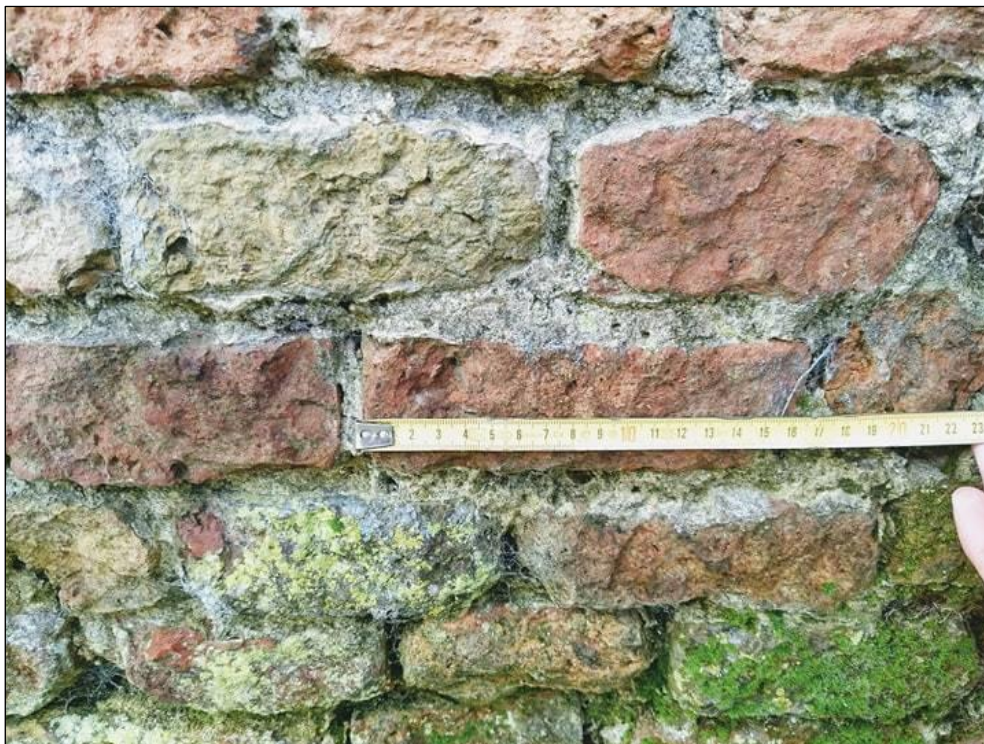
Figuur 21: Baksteentype noordelijk gebouw (datering vermoedelijk 1818).
