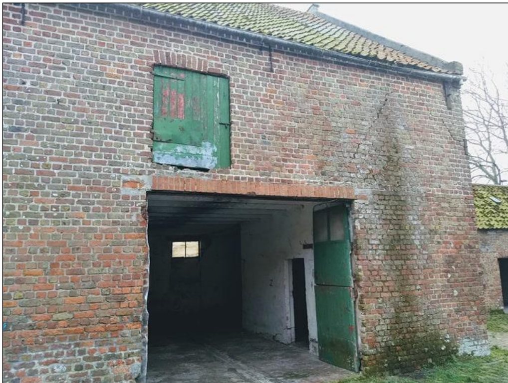
Figuur 28: Westelijk deel zuidelijk gebouw.
