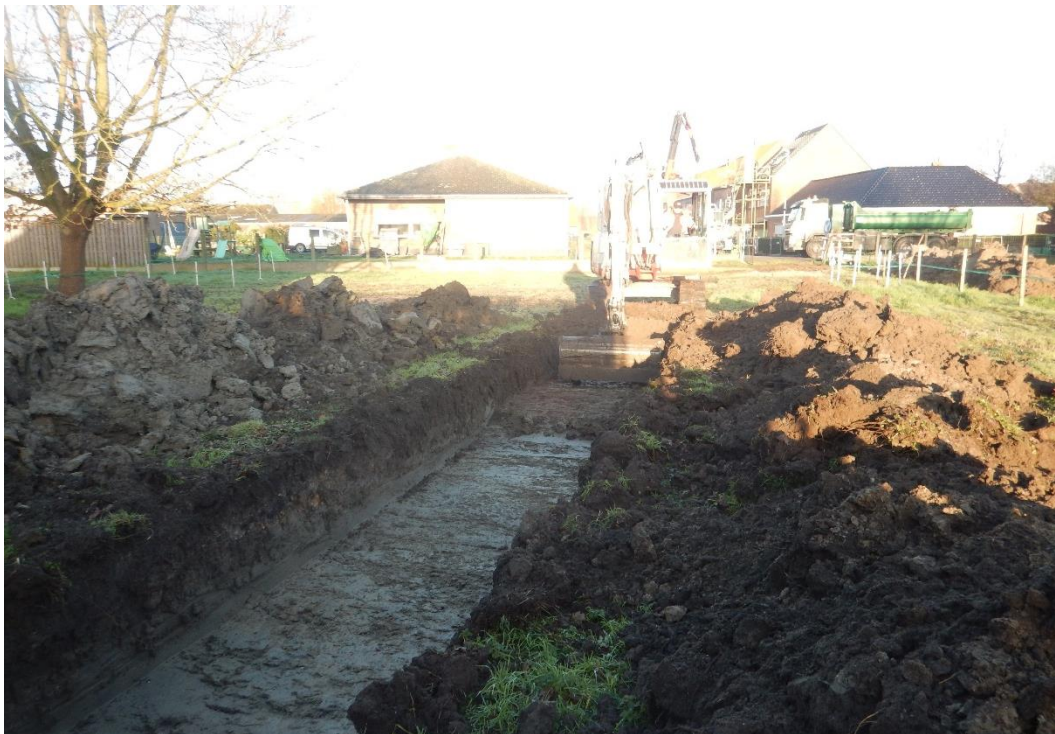
Figuur 3: Zicht op het aanleggen van sleuf 2 binnen fase 1.
