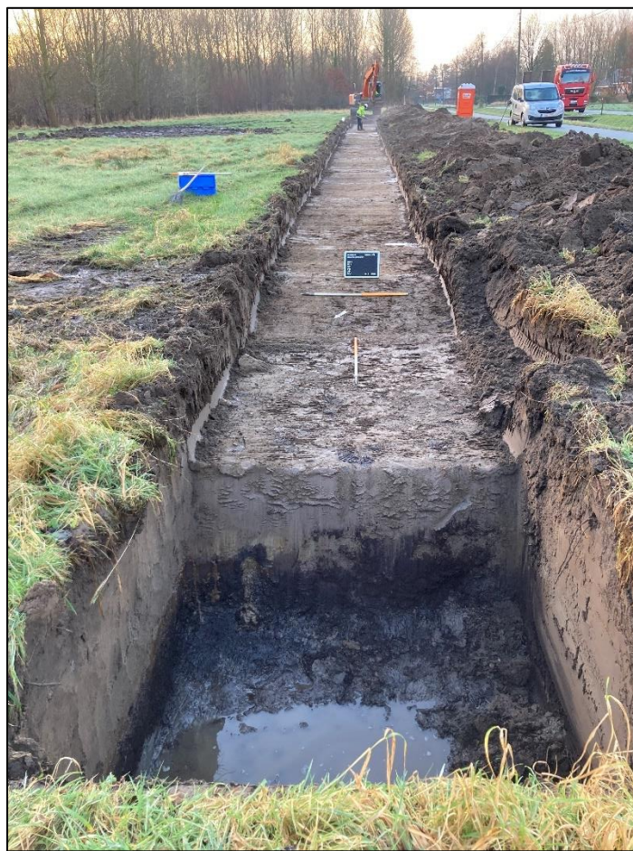
Figuur 23: Zicht op werkput 1
