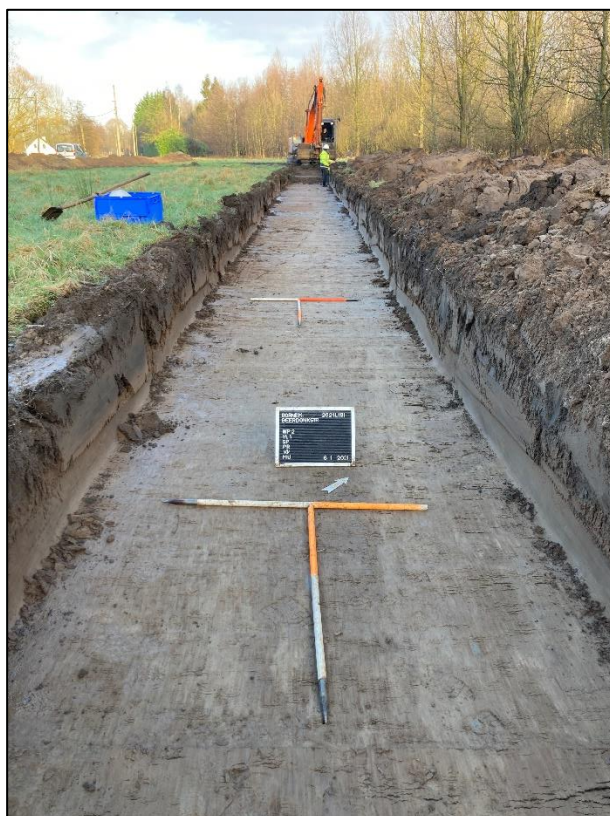
Figuur 27: Zicht op werkput 2
