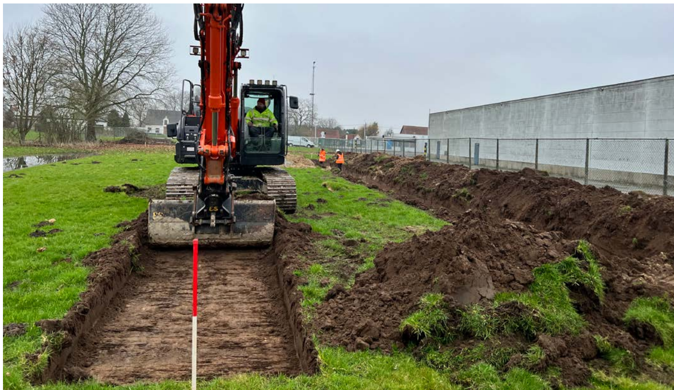
Figuur 44: Aanleg van de sleuven en registratie van de sporen
