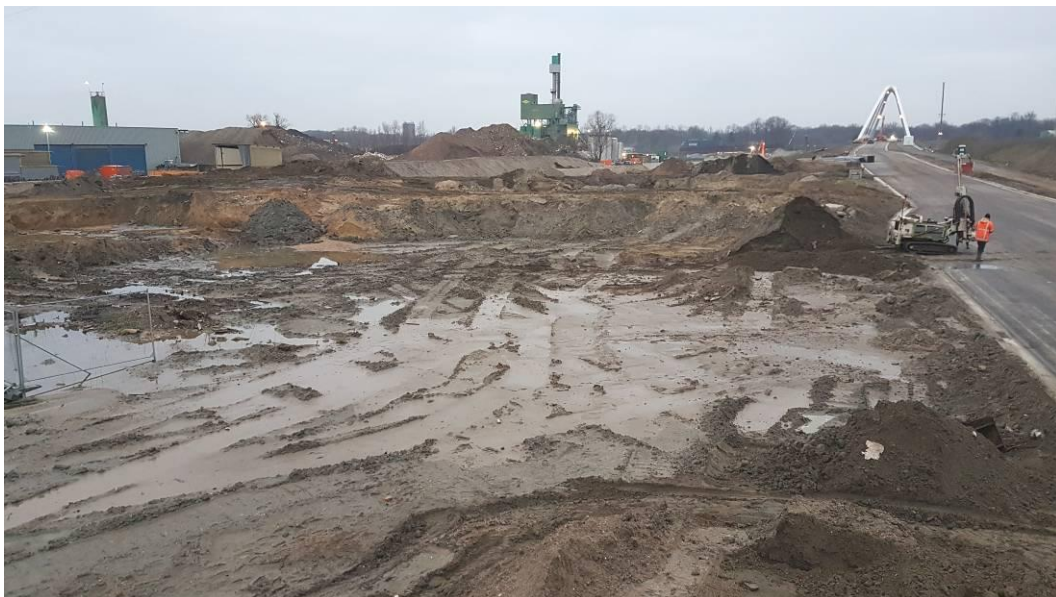
Afb. 14. Actuele situatie van het zuidelijke deel van het onderzoeksgebied nabij boring 21, gezien in noordwestelijke richting, met de nieuwe baan op de aanloophelling aan de rechterzijde. Opnamedatum: 21-01-2022.
