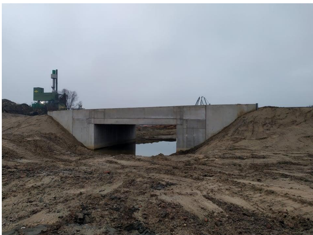
Afb. 17. Tunnelbak tussen de aanloophelling en de lus, ter hoogte van boring 16. Opnamedatum: 21-01-2022.
