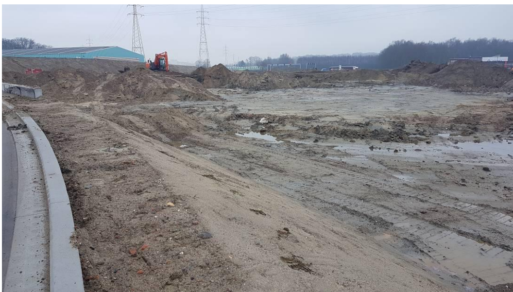
Afb. 15. Actuele situatie van het centrale deel van het onderzoeksgebied nabij boring 16, gezien in zuidelijke richting. Opnamedatum: 21-01-2022.
