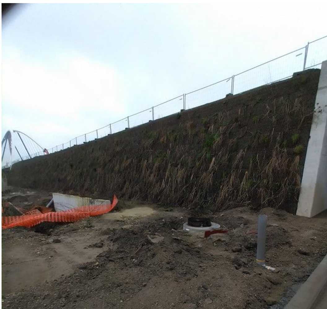
Afb. 19. Aanloophelling ter hoogte van boring 25 en 26, met links de nieuwe brug en rechts de tunnelbak waar de lus onder de aanloophelling doorloopt. Opnamedatum: 21-01-2022.
