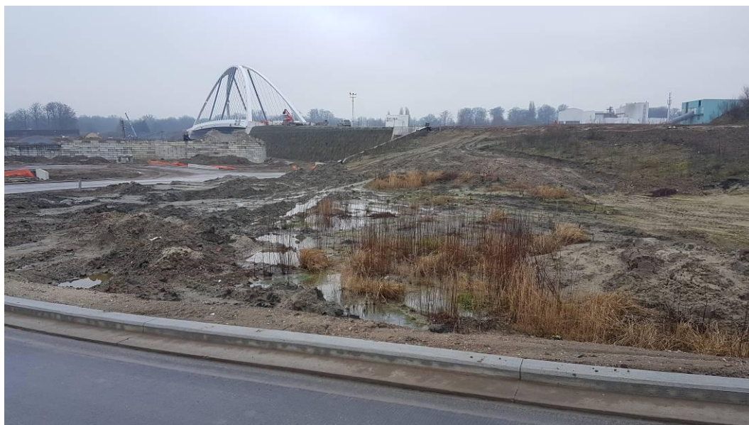
Afb. 16. Actuele situatie van het noordelijke deel van het onderzoeksgebied, genomen vanaf de lus (halverwege tussen boring 7 en 8), gezien in noordelijke richting, richting brughoofd. Opnamedatum: 21-01-2022.
