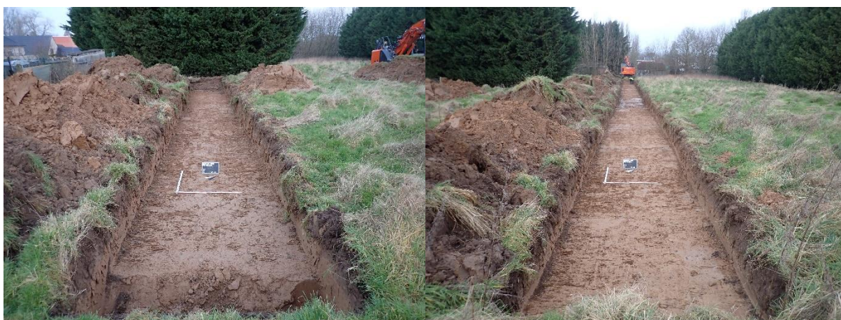
Figuur 28: Overzichtsfoto's WP1 (L) en WP2 (R) in noordwestelijke richting (© J. Verrijckt Bvba)
