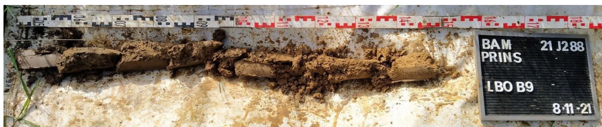
Figuur 10: Boring 9 (© J. Verrijckt Bvba)
