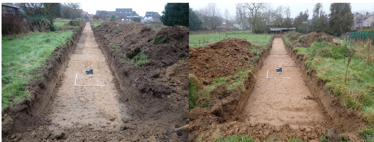
Figuur 30: Overzichtsfoto's WP5 (L) in zuidoostelijke richting en WP6 (R) in noordwestelijke richting (© J. Verrijckt Bvba)
