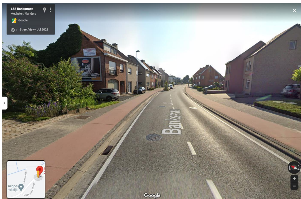
Figuur 4: Zicht vanuit het westen op de Bankstraat ter hoogte van huisnummer 130 (Google Maps, 2022)
