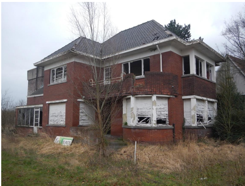
Figuur 8 Zicht op de woning nr. 129.
