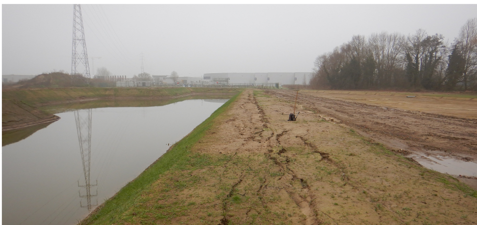
Figuur 2. Zicht op het reeds door BAAC Vlaanderen onderzochte deel van het gebied.
