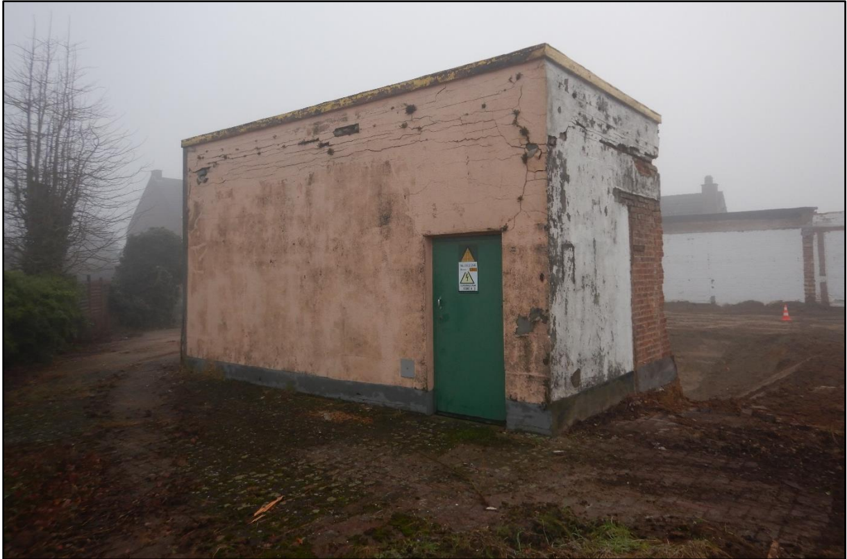
Figuur 1 Elektriciteitscabine met achterliggende kelder in het noordelijke deel van het plangebied.
