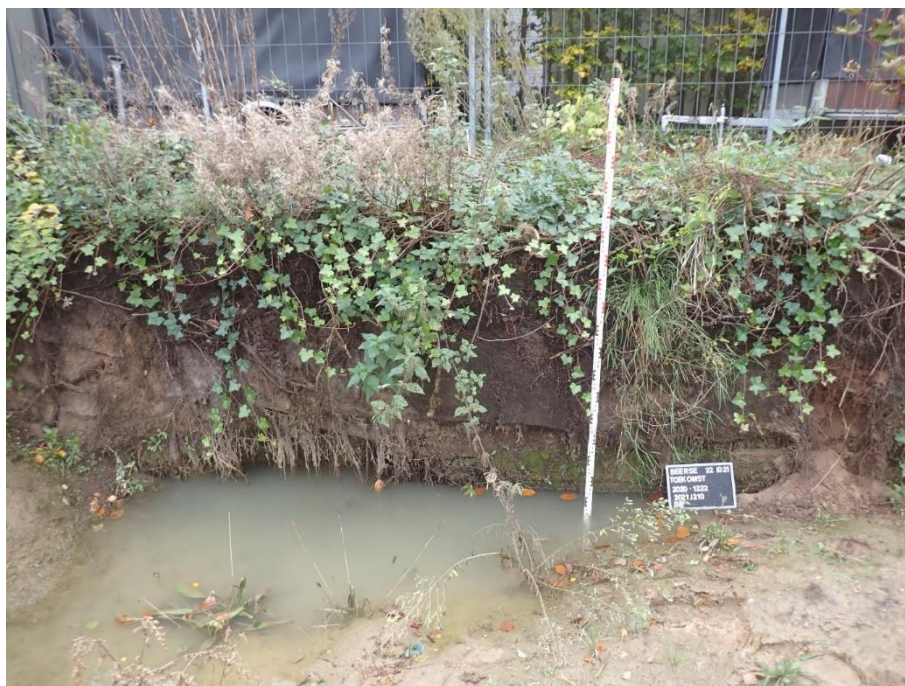
Figuur 11: foto genomen ter hoogte van boring 8 betreft reeds afgegraven terrein - kijkrichting zuid (© J. Verrijckt)
