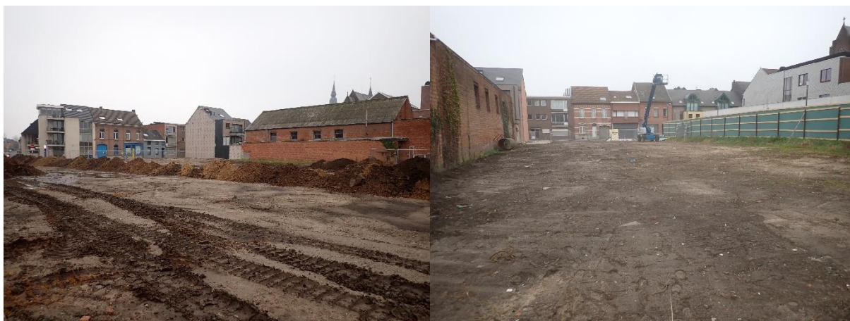
Figuur 24: Toestand terrein tijdens het proefsleuvenonderzoek: oostelijke zone (L) en westelijke zone (R) (© J. Verrijckt Bvba)
