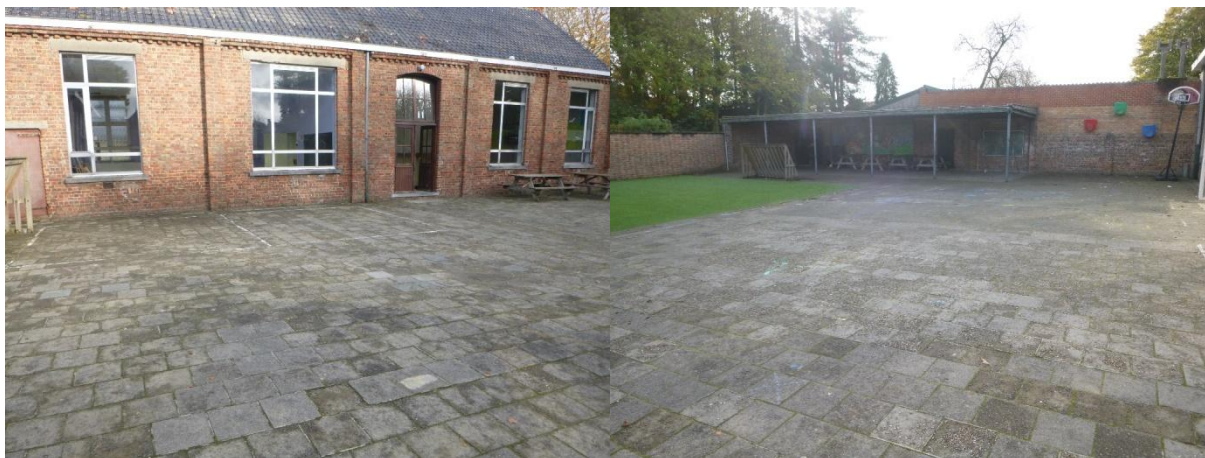
Figuur 11: Omgevingsfoto's van het projectgebied ter hoogte van BP2, genomen in noordelijke (links) en zuidelijke richting (rechts).
