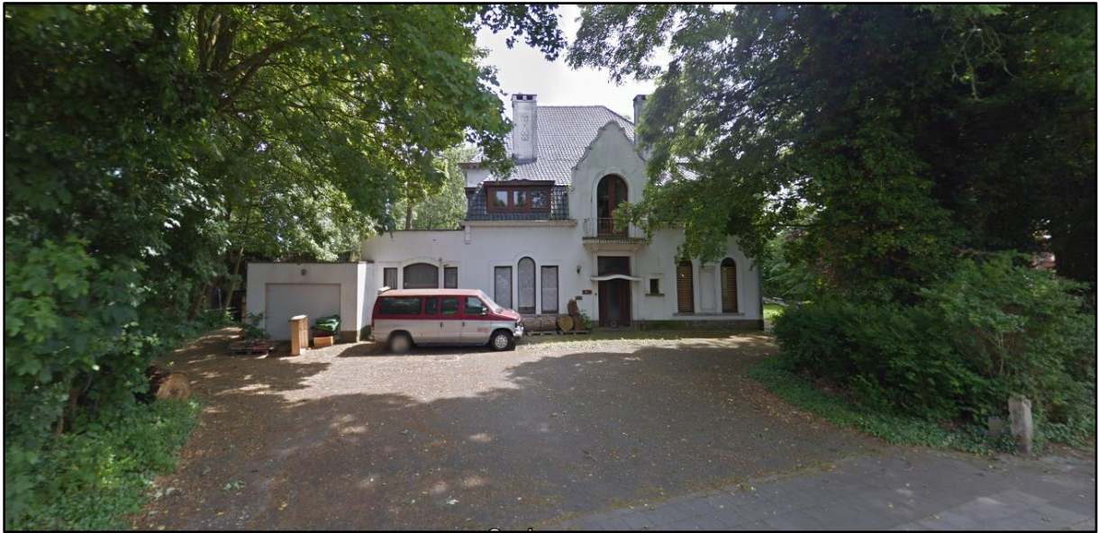
Figuur 2 Zicht op de woning gezien vanaf de straatzijde (bron: https://www.google.com/maps ).
