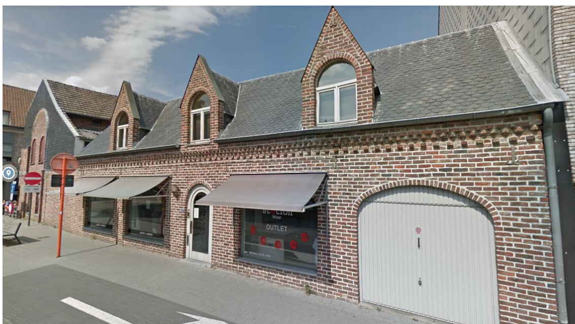
Figuur 6: Zicht op het huidige handelspand aan de Romboutstraat 21 (Google maps, 2022)
