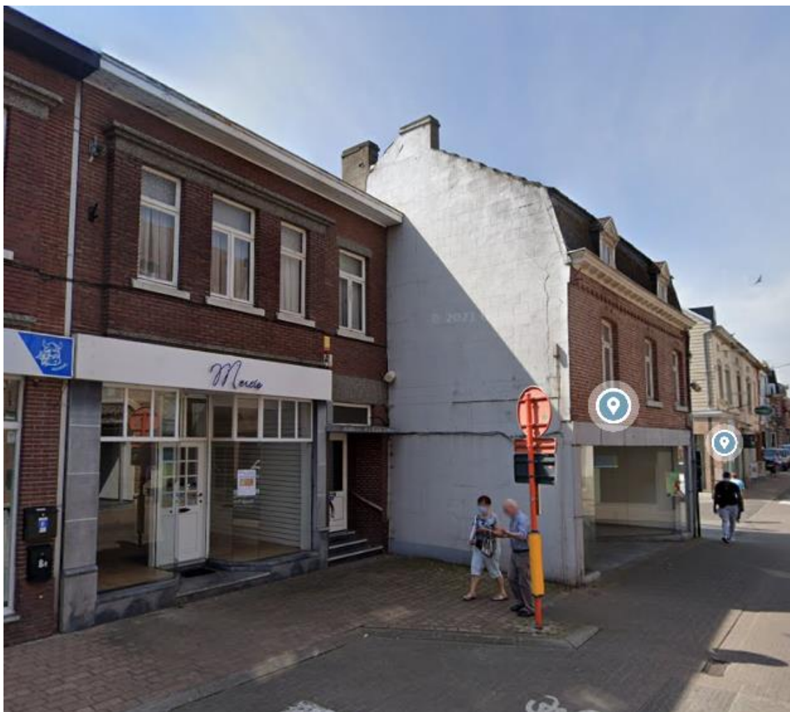
Figuur 5: Zicht op de huidige woningen en handelspanden aan de Korenstraat 10 en 12 (Google maps, 2022)
