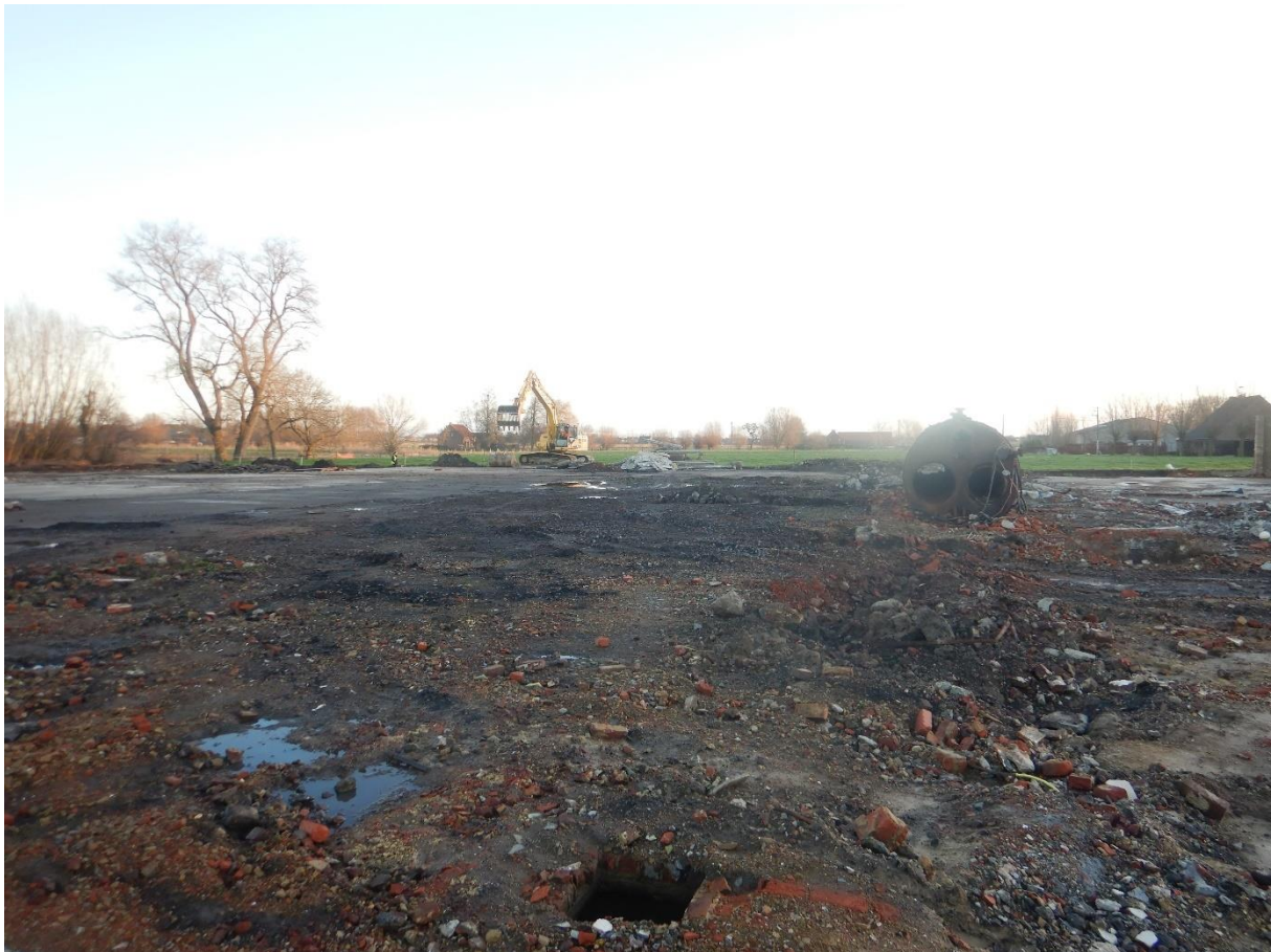
Figuur 15: Zicht op het terrein voor het aanleggen van de proefsleuven.
