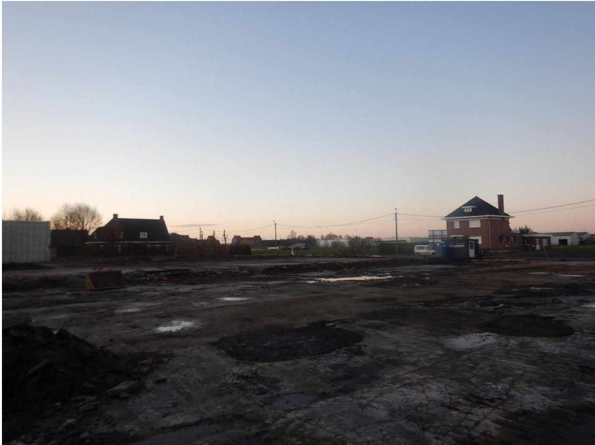
Figuur 17: Zicht op het terrein.
