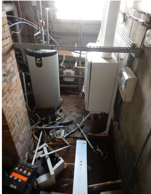
Figuur 8. Zicht op het voormalige ouderenverblijf. Onder: de verdiepte technische ruimte van het gebouw.
