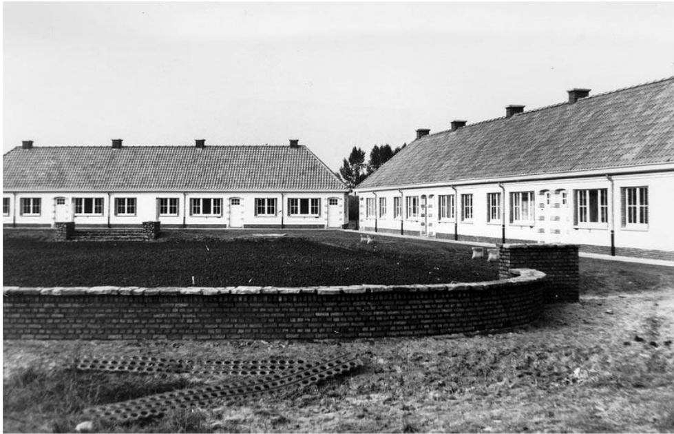
Figuur 35. Bouw van de zogenaamde 'Apostelhuizen' aan de Zelestraat in 1952 29 . Let op de moerasijzers op de voorgrond.
