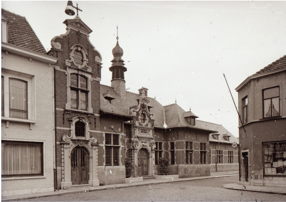
Figuur 34. Zicht op de voormalige materniteit in de Lepelstraat 27 .
